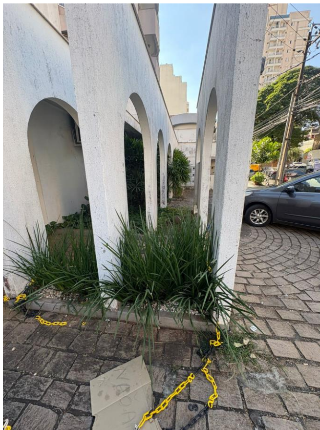
Figura 5: Condições da edificação atual na data de 22/07/2025.
