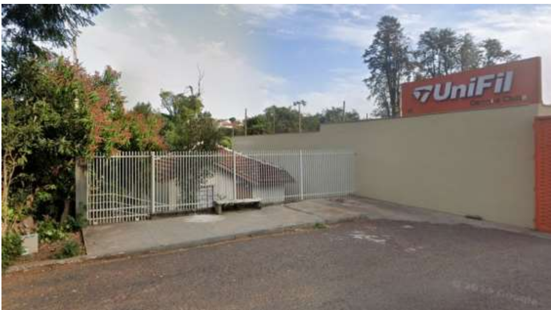
Figura 58 – Edificação nas Proximidades. Fonte: ONE.
