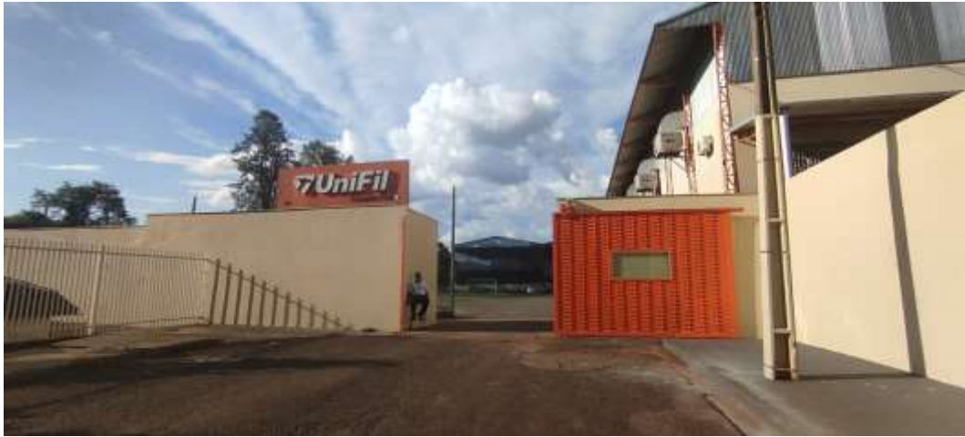
Figura 131 – Acesso Secundário do Empreendimento pela Rua Monte Castelo. Fonte: ONE.
