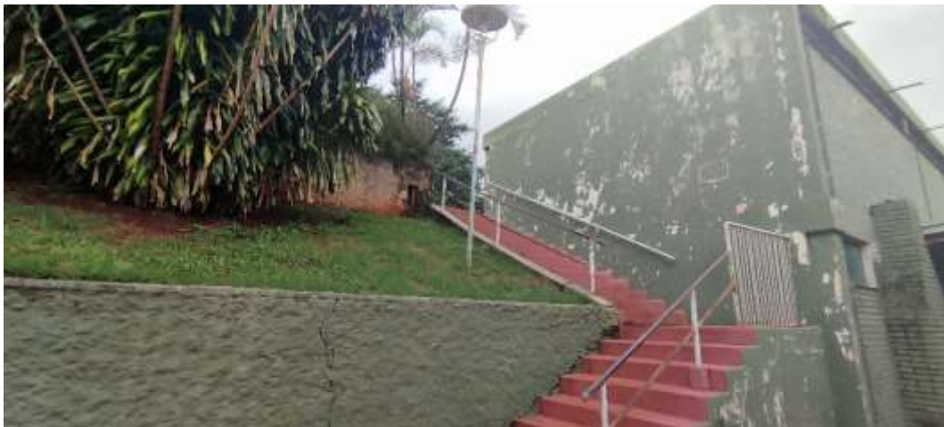
Figura 100 – Iluminação Interna. Fonte ONE.
