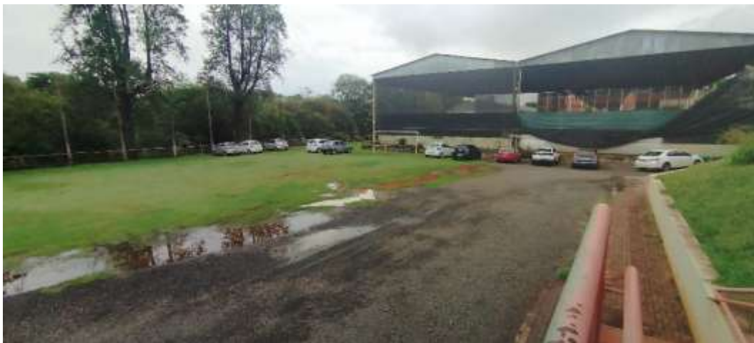
Figura 98 – Canaleta de Drenagem. Fonte: ONE.
