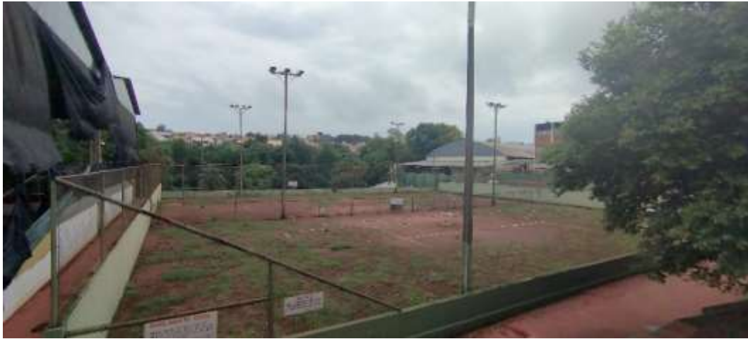
Figura 99 – Iluminação Interna. Fonte ONE.
