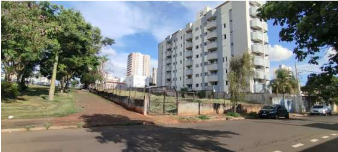
Figura 59 – Edificação nas Proximidades. Fonte: ONE.
