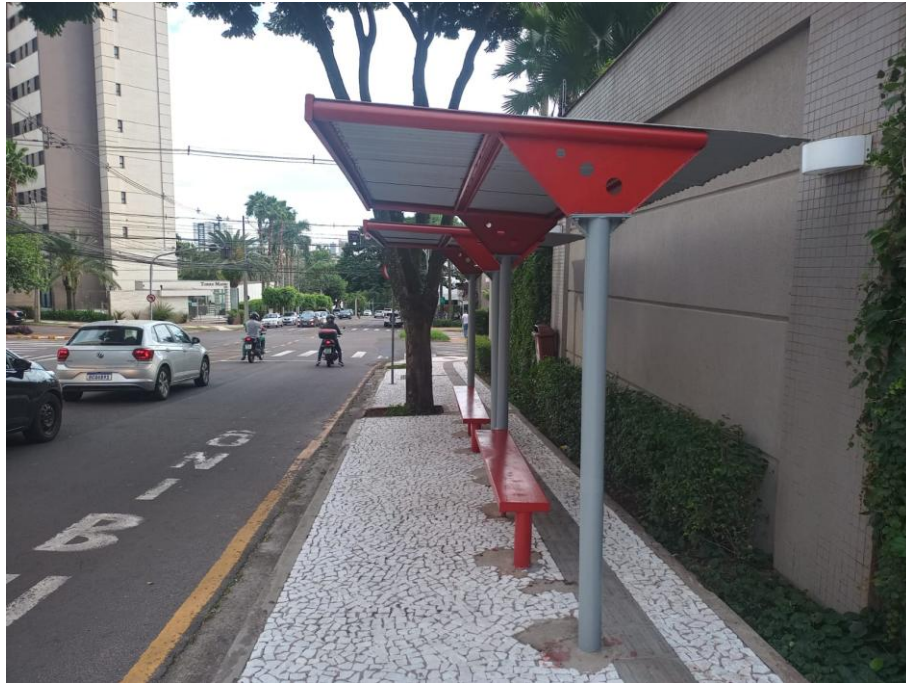
Figura 134: Ponto de ônibus na Rua João Wyclif. Fonte: Master Ambiental, 2024.
