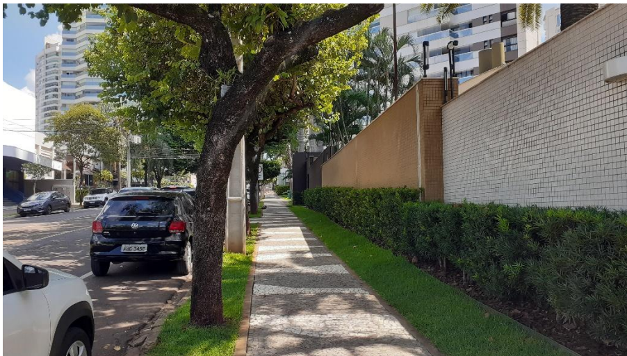
Figura 103: Calçada no entorno em bom estado de conservação e sem dispositivo de acessibilidade. Fonte: Master Ambiental, 2024.
