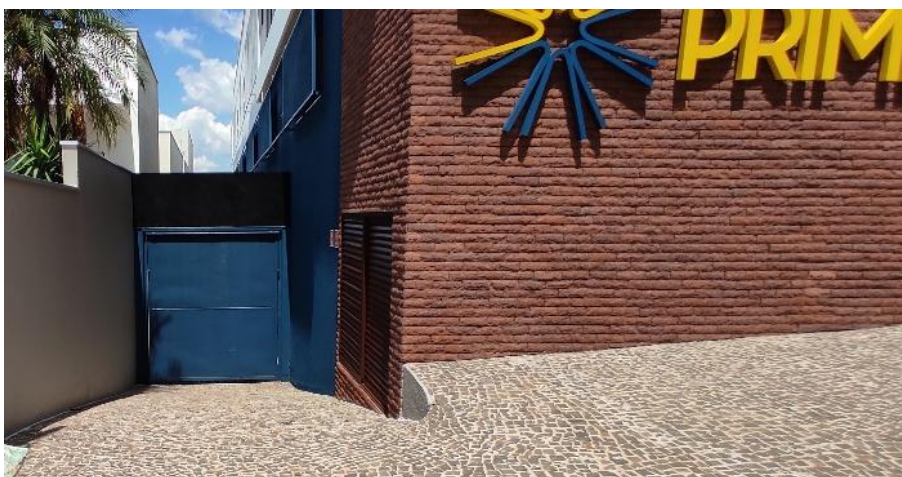
Figura 83: Acesso ao estacionamento do empreendimento. Fonte: Master Ambiental, 2024.
