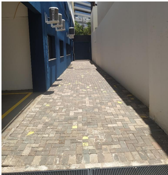
Figura 80: Piso do estacionamento descoberto. Fonte: Master Ambiental, 2024.
