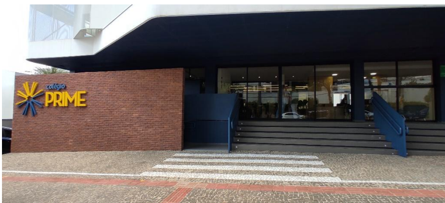
Figura 84: Acesso dos pedestres ao empreendimento. Fonte: Master Ambiental, 2024.
