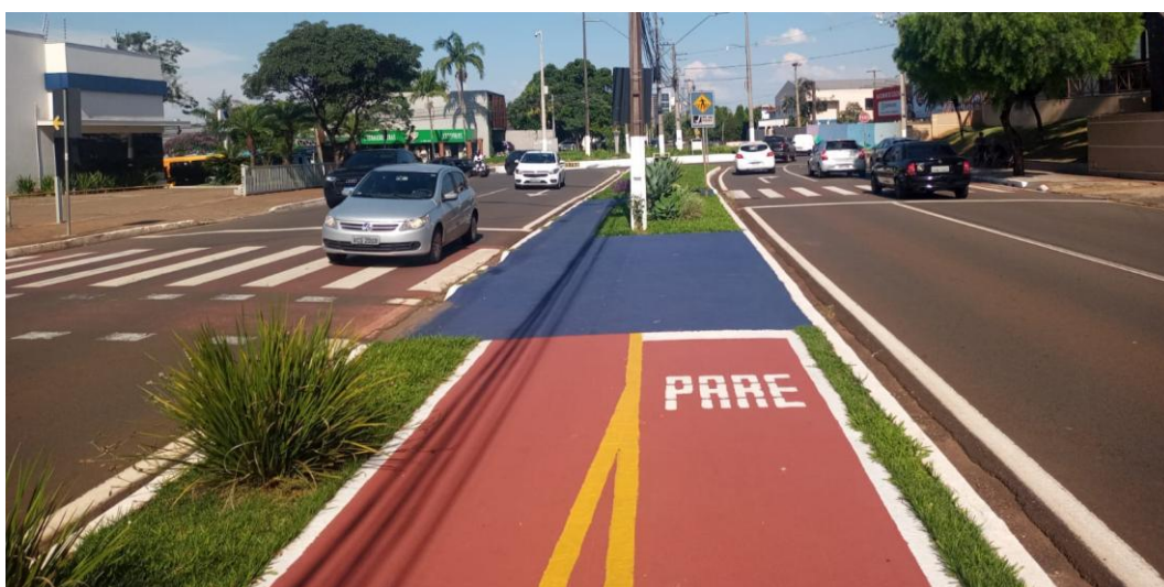
Figura 122: Travessia de ciclistas na Av. Madre Leônia Milito. Fonte: Master Ambiental, 2024.
