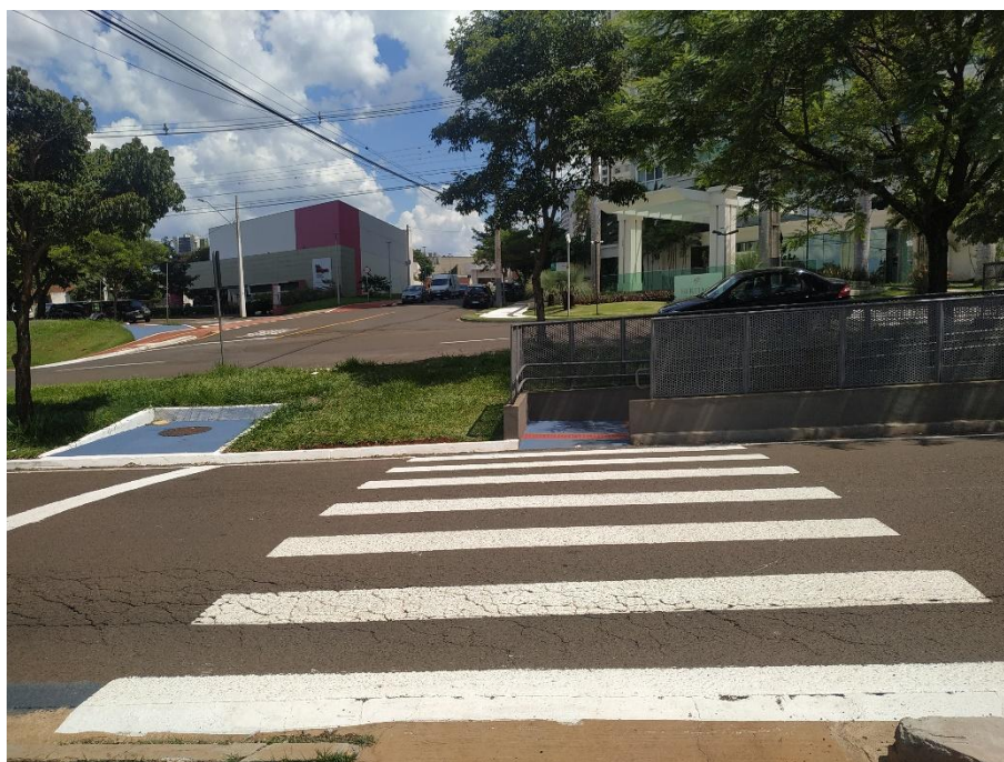
Figura 109: Faixa de travessia de pedestre acessível até o dispositivo de travessia da via na Rua Montevideu. Fonte: Master Ambiental, 2024.
