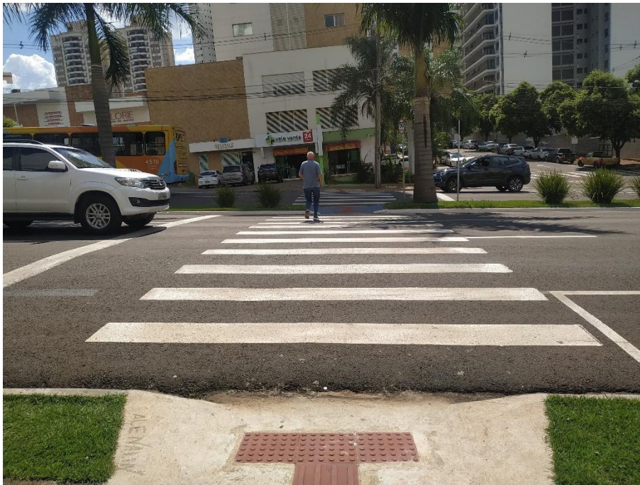
Figura 106: Travessia de pedestre no entorno com rebaixo e dispositivo de acessibilidade. Fonte: Master Ambiental, 2023.
