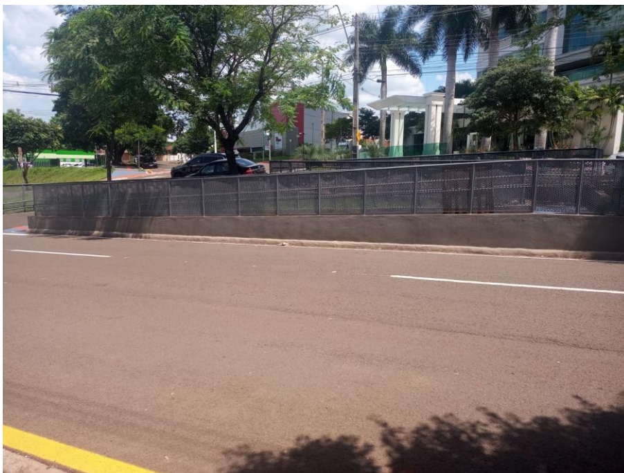
Figura 110: Dispositivo de travessia de pedestres na Rua Montevideú. Fonte: Master Ambiental, 2024.
