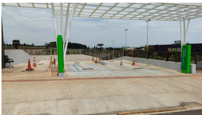
Figura 20: Filas paralelas de acesso ao empreendimento. Fonte: Unimed, 2025.
