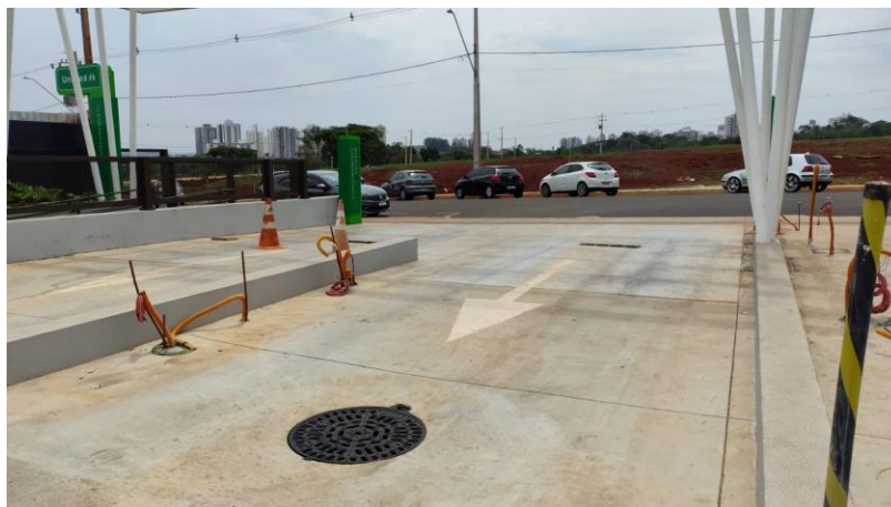
Figura 19: Filas paralelas de acesso ao empreendimento. Fonte: Unimed, 2025.
