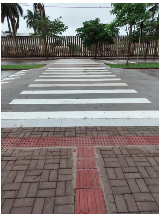
Figura 7: Travessia elevada implantada na Av. dos Expedicionários. Fonte: Unimed, 2025.
