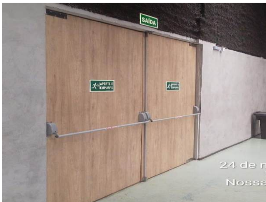
Figura 17: Saída de emergência no interior do empreendimento. Fonte: Master Ambiental, 2025.
