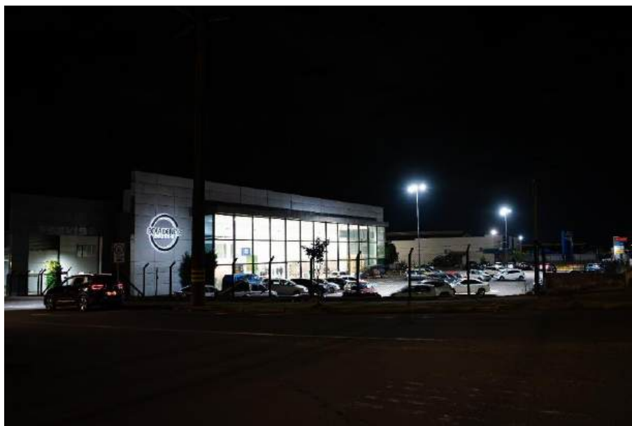
Figura 58: Iluminação das áreas externas do empreendimento. Fonte: Igreja Bola de Neve, 2025.
