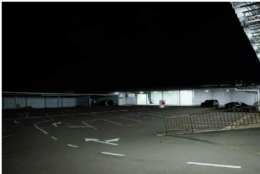
Figura 57: Iluminação das áreas externas do empreendimento. Fonte: Igreja Bola de Neve, 2025.
