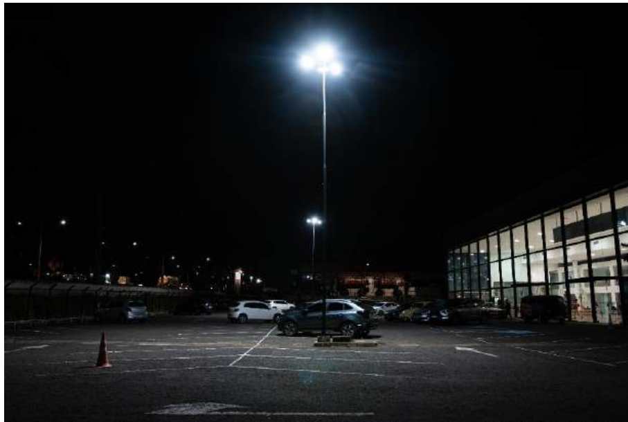
Figura 56: Iluminação das áreas externas do empreendimento. Fonte: Igreja Bola de Neve, 2025.
