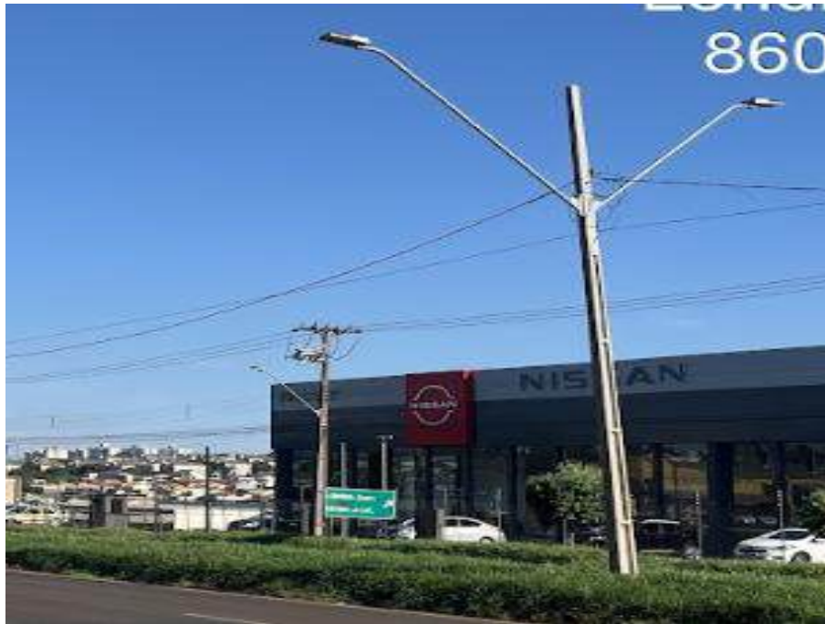
Figura 50: Postes de luz na Av. Brasília. Fonte: Master Ambiental, 2025.
