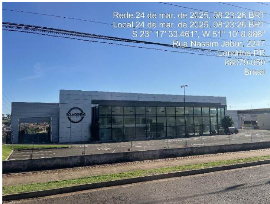
Figura 83: Logomarca na fachada principal. Fonte: Master Ambiental, 2025.
