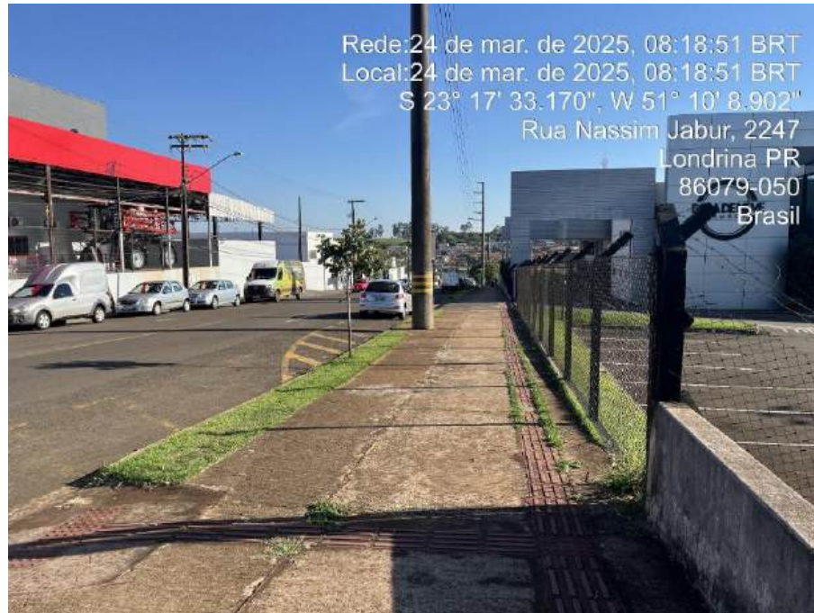
Figura 119: Acesso atual do empreendimento na R. Seimu Oguido, apresentando piso tátil, guia rebaixada e faixa permeável adequados. Fonte: Master Ambiental, 2025.
