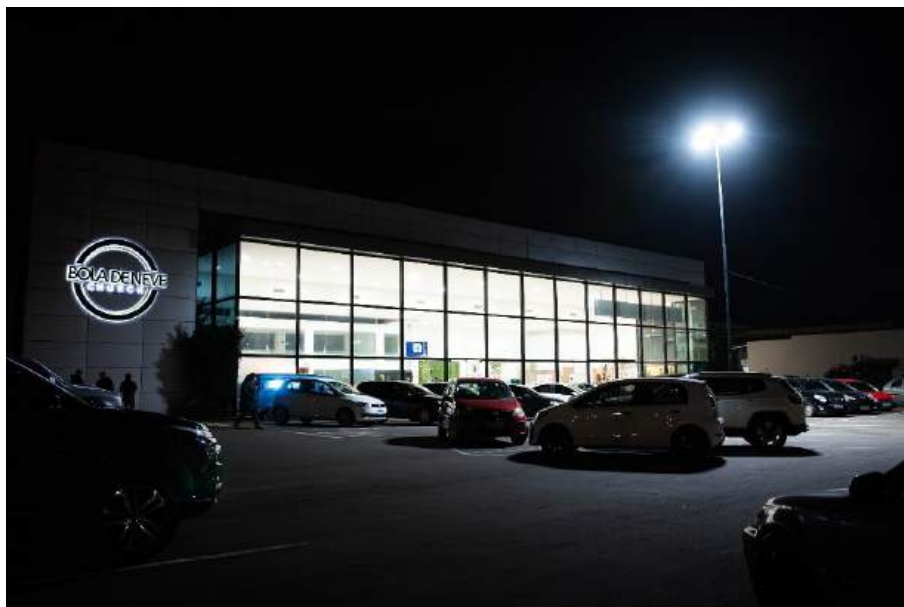
Figura 55: Iluminação das áreas externas do empreendimento. Fonte: Igreja Bola de Neve, 2025.
