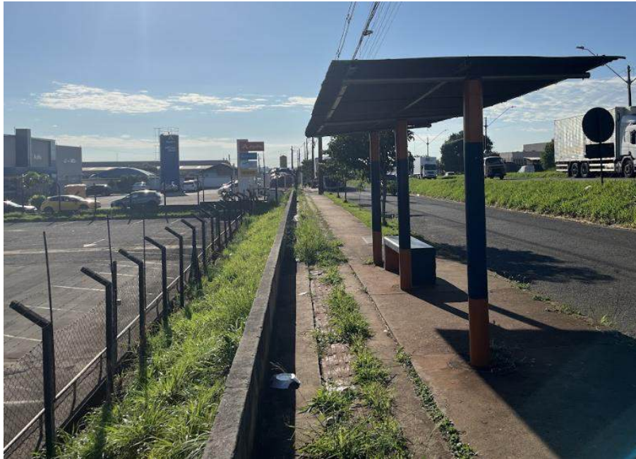
Figura 107: Ponto de ônibus na Av. Brasília próximo ao terreno do empreendimento. Fonte: Master Ambiental, 2025.
