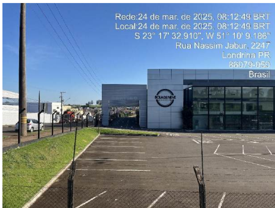
Figura 2: Fachada do empreendimento. Elaboração: Master Ambiental, 2025.
