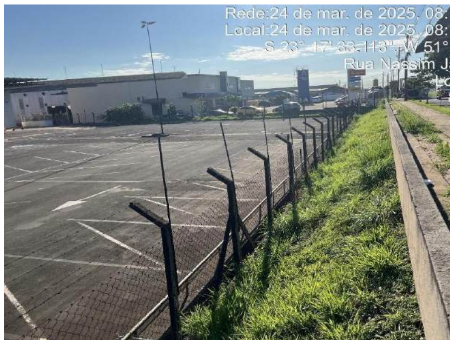
Figura 21: Área permeável no interior do lote do empreendimento. Fonte: Master Ambiental, 2025.
