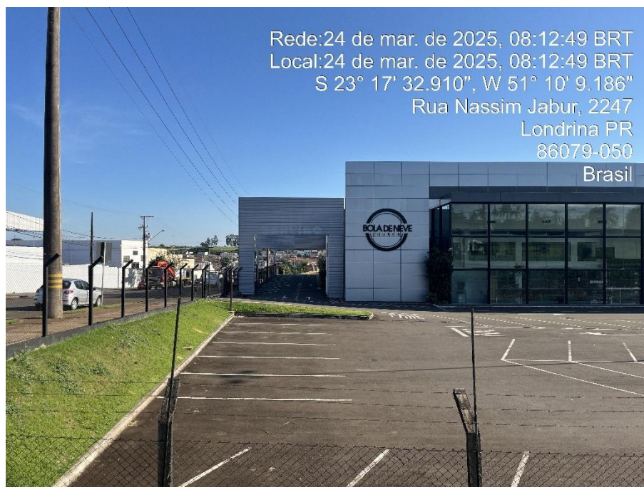
Figura 3: Fachada do empreendimento. Elaboração: Master Ambiental, 2025.
