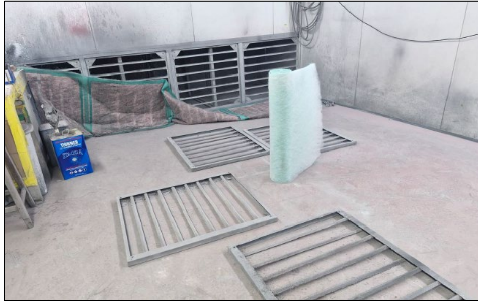
Figura 3 - Detalhe do processo de troca do filtro de exaustão da cabine de pintura, evidenciando a correta execução da medida mitigadora prevista no EIV.
