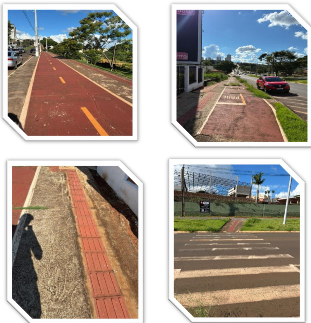
Figura 12: Situação atual de calçadas e acessibilidade.
