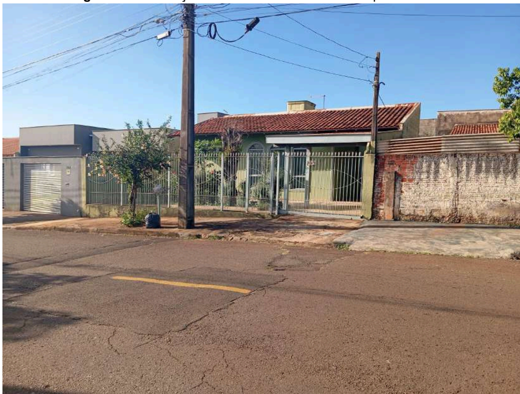
Figura 41- Edificações na área de influência do empreendimento.
