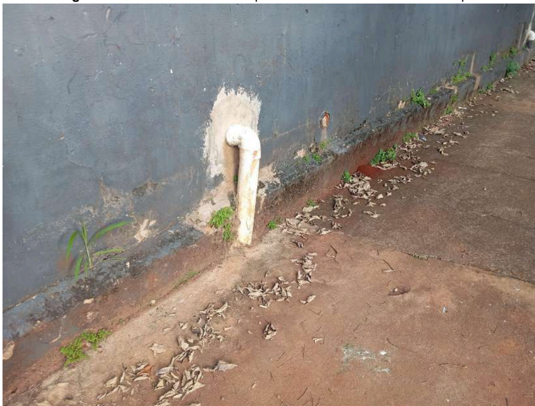
Figura 34- Saida da Caixa SAO para conexão com a rede da Sanepar.
