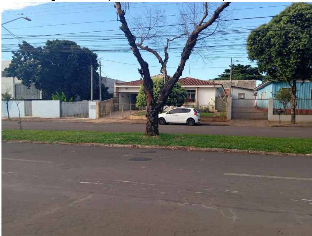
Figura 52- Edificações na área de influência do empreendimento.
