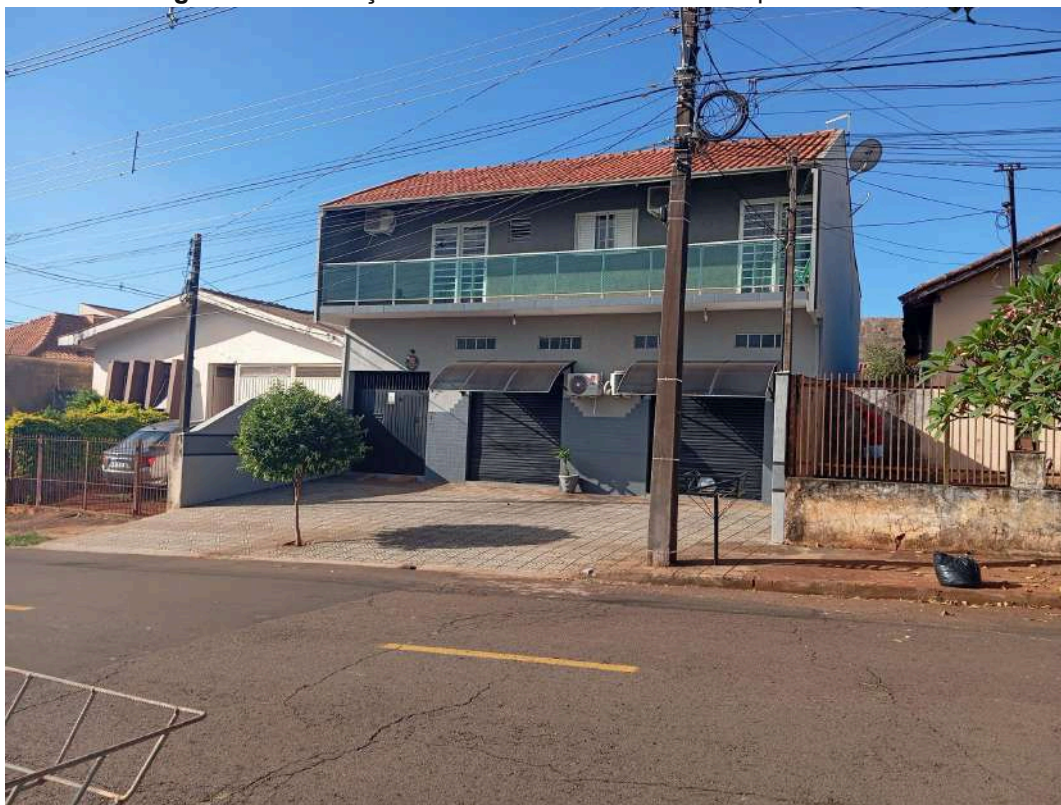
Figura 43- Edificações na área de influência do empreendimento.
