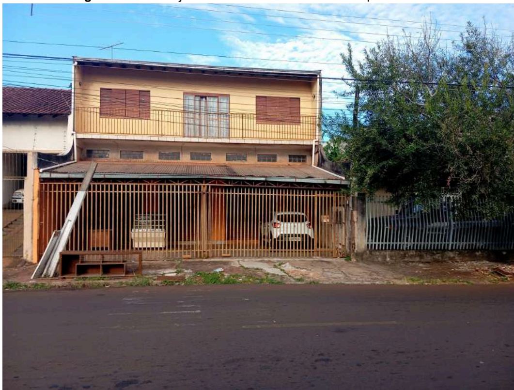
Figura 53- Edificações na área de influência do empreendimento.
