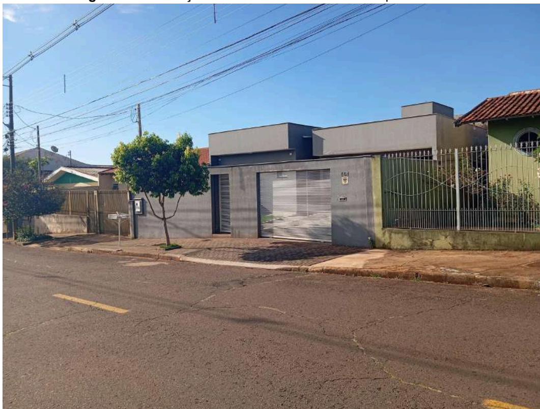
Figura 42- Edificações na área de influência do empreendimento.
