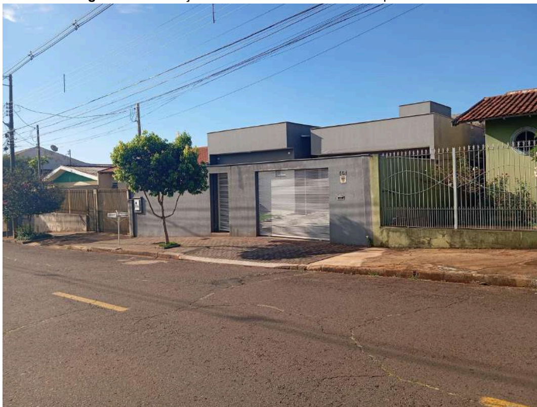
Figura 42- Edificações na área de influência do empreendimento.
