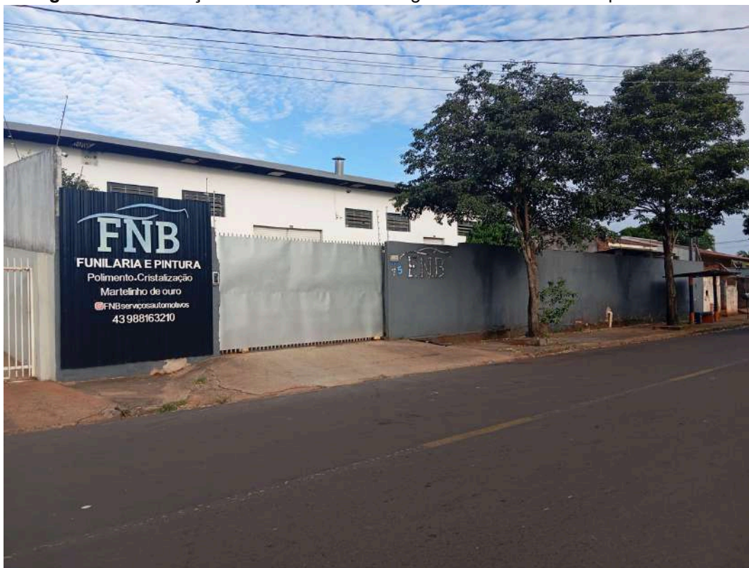
Figura 67- Sinalização Viária Horizontal Desgastada - Frente ao Empreendimento.
