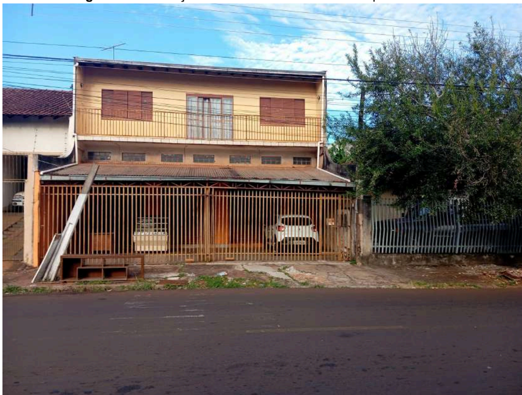
Figura 53- Edificações na área de influência do empreendimento.
