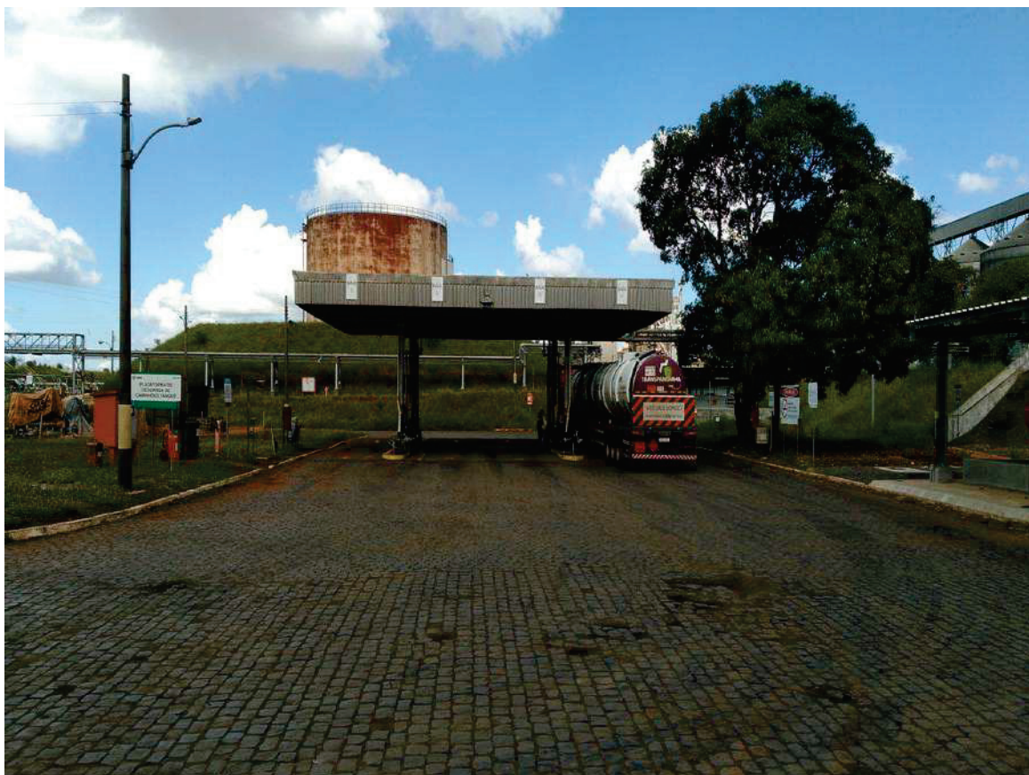
Figura 12 - Plataforma de descarregamento de caminhões-tanque (etanol), com cobertura independente e acesso por pavimento de pedra portuguesa
