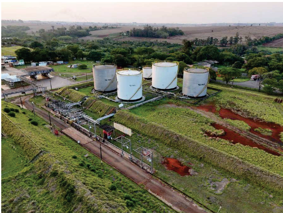
Figura 5 - Vista aérea dos tanques TQ-1624, TQ-1625 E TQ-1623, inseridos em diques de contenção gramados, com trilho ferroviários de acesso a plataforma de descarregamento em primeiro plano
