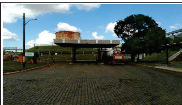
Figura 55 - Área de descarregamento dos caminhões-tanque
