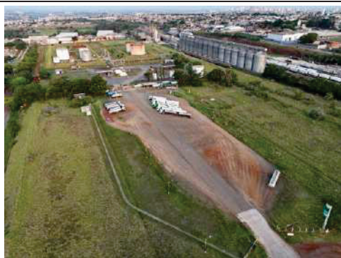
Figura 32 – Vista aérea do estacionamento
