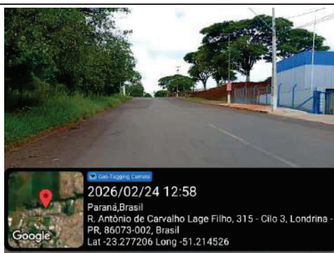
Figura 43 - Pavimentação e sinalização no entorno
