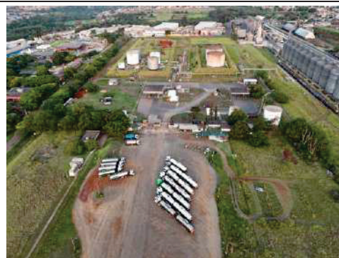
Figura 33 – Vista aérea do pátio de caminhões
