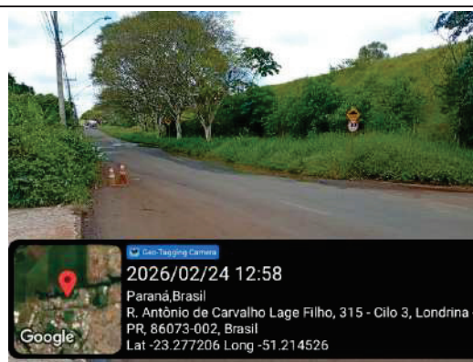
Figura 48 - Pavimentação e sinalização (Estrada dos Amores)
