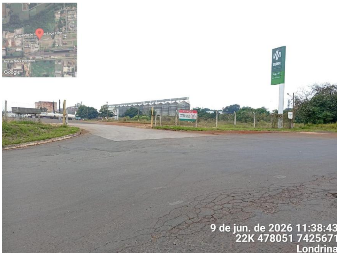
Figura 8 – Registro da entrada do empreendimento na rua Alcenir Bueno.
