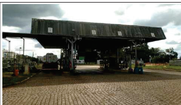
Figura 54 - Área de carregamento dos caminhões-tanque
