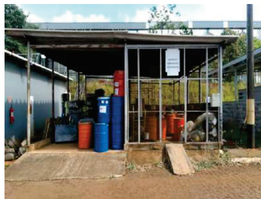
Figura 19 - Vista ampliada da central de resíduos evidenciando setor aberto coberto (tambores laranja, azul, materiais volumosos) e setor fechado da gaiola metálica ao fundo
