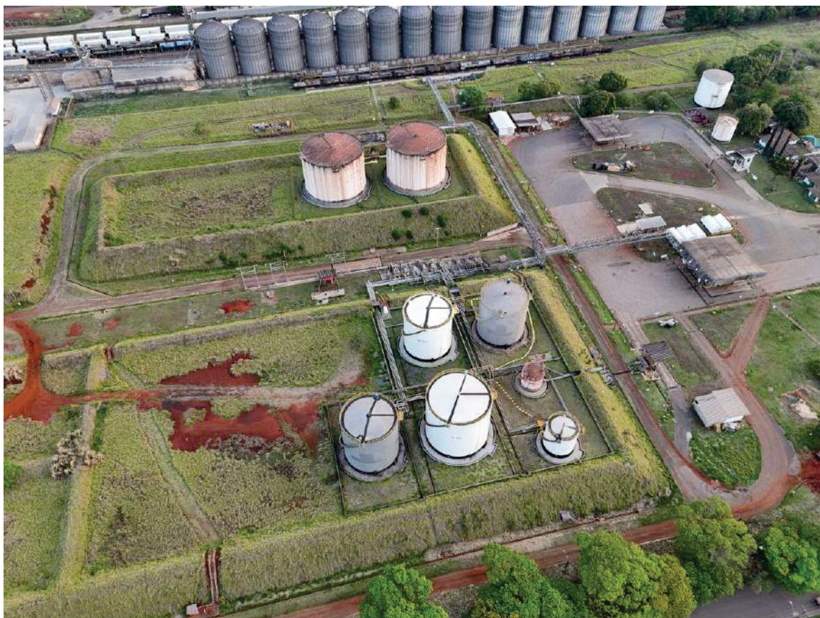
Figura 2 - Vista aérea panorâmica evidenciando os tanques aéreos com seus respectivos diques de contenção, o rack de tubulações, e ao fundo, os silos da empresa vizinha (Cocamar) e a linha ferroviária
