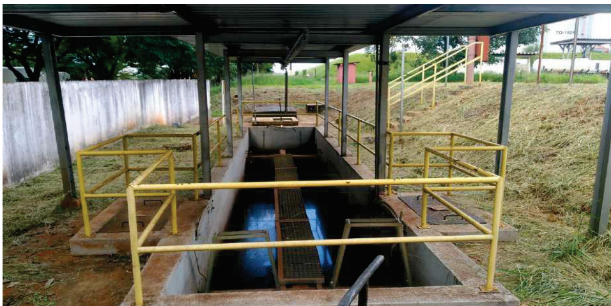
Figura 15 - Sistema de Separação de Água e Óleo (CSAO) da Base Vibra Energia S.A – Londrina/PR
