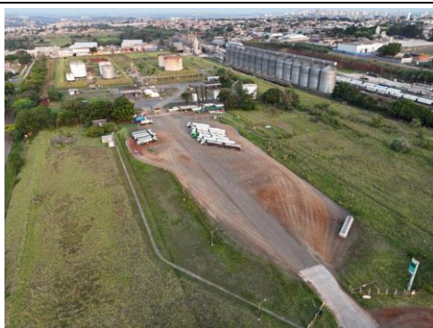
Figura 7. Vista aérea do estacionamento
