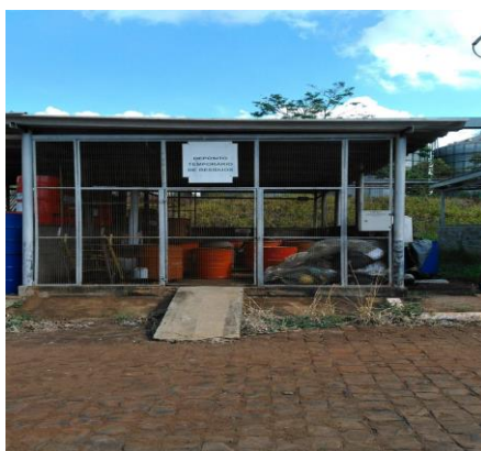
Figura 9. Central de Resíduos: setor fechado com tambores laranjas (Classe I)
