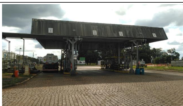
Figura 43. Área de carregamento dos caminhões-tanque
