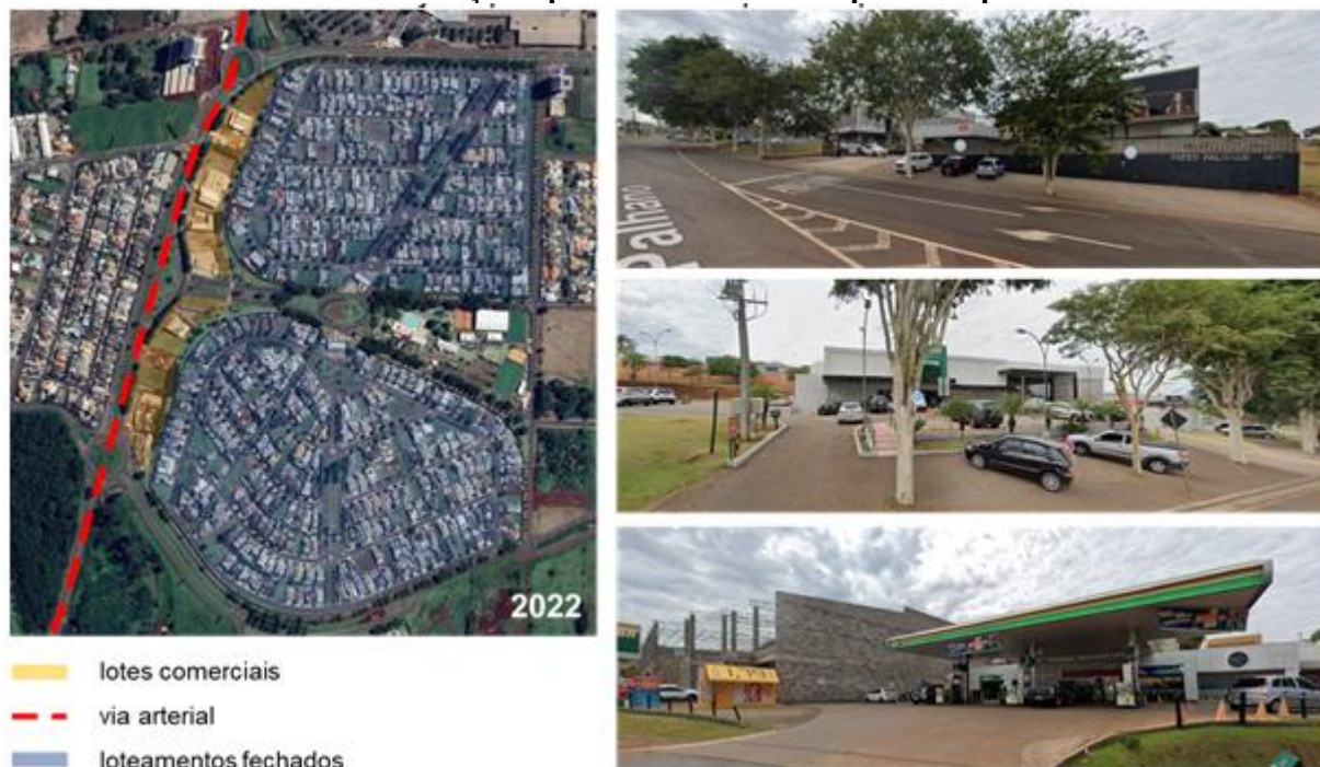
Figura 42 – Exemplo de paisagem urbana resultante de barreira física de loteamento fechado disfarçada por lotes “abertos” para via pública
