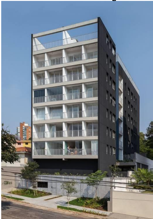
Figura 39 – Fachada e perspectiva do edifício
