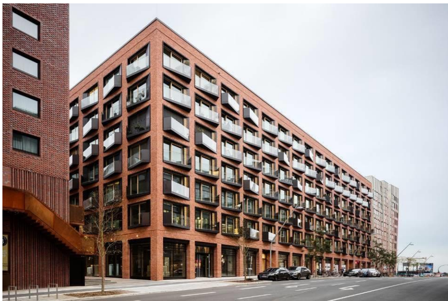
Figura 18 – Fachada do edifício
