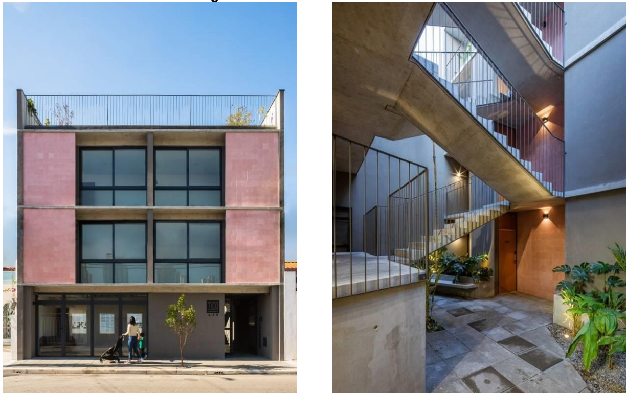
Figura 37 – Fachada e interior do edifício
