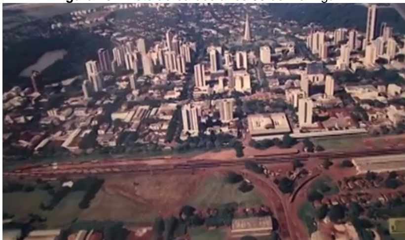
Figura 10 – Foto aérea dos anos 80 de Maringá-PR
