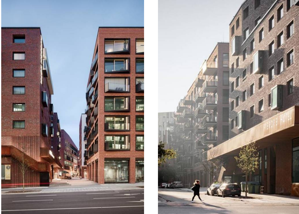
Figura 19 – Fachadas do edifício
