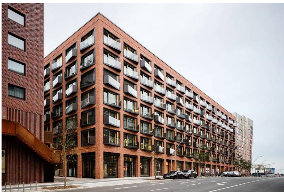
Figura 18 – Fachada do edifício
