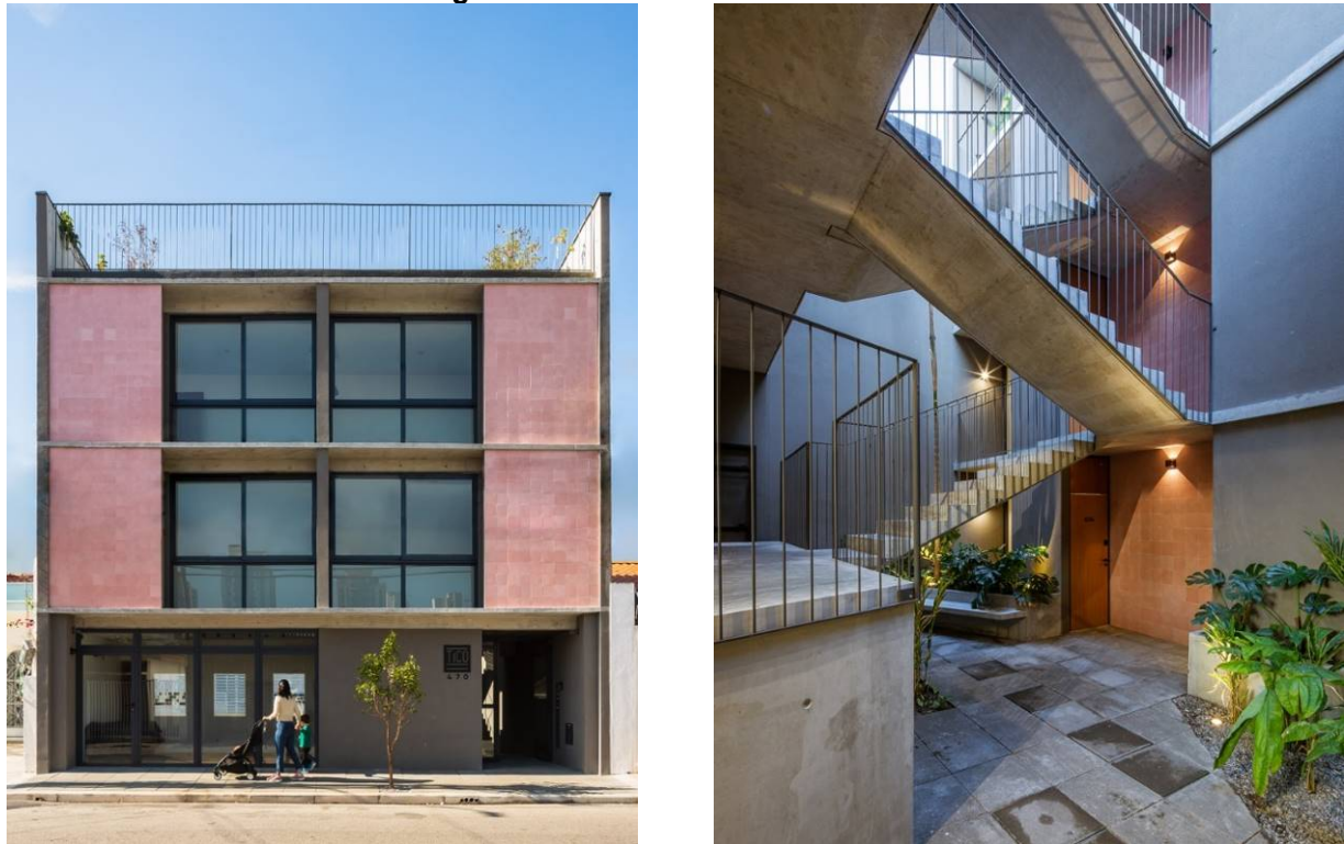
Figura 37 – Fachada e interior do edifício
