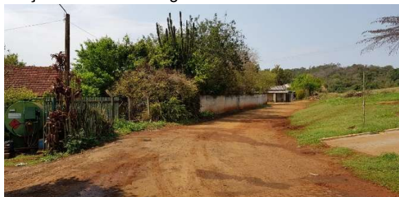
Vias de acesso – sem pavimentação
