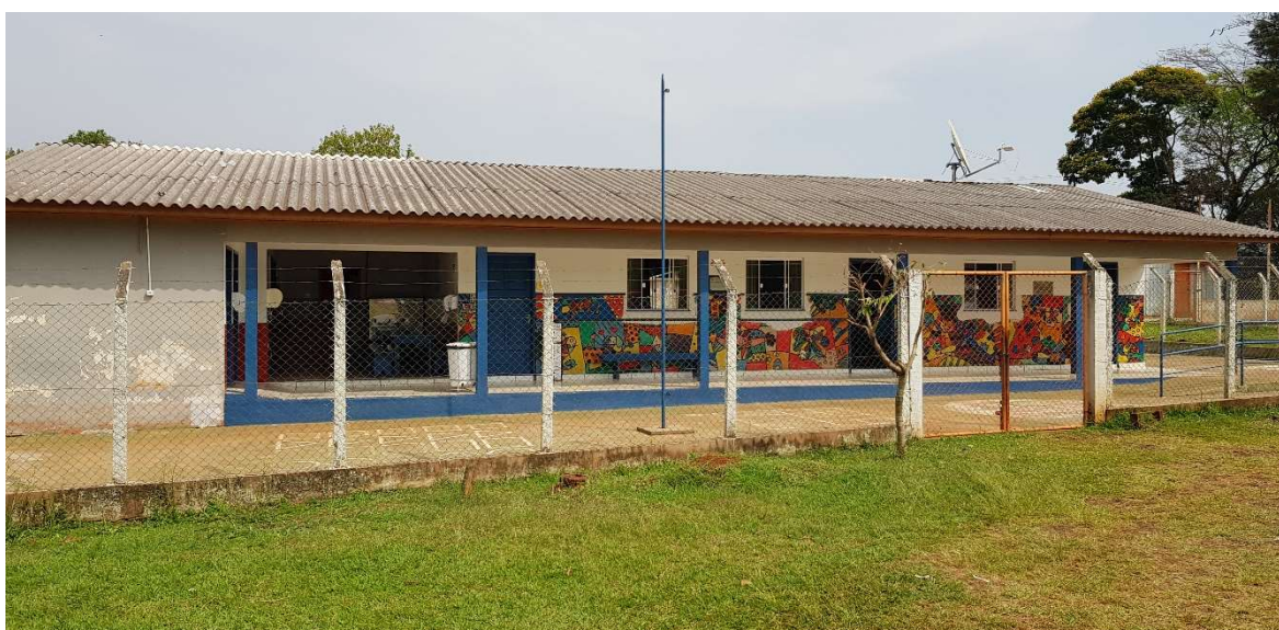
Figura 7 – Escola Municipal do Patrimônio Guairacá
