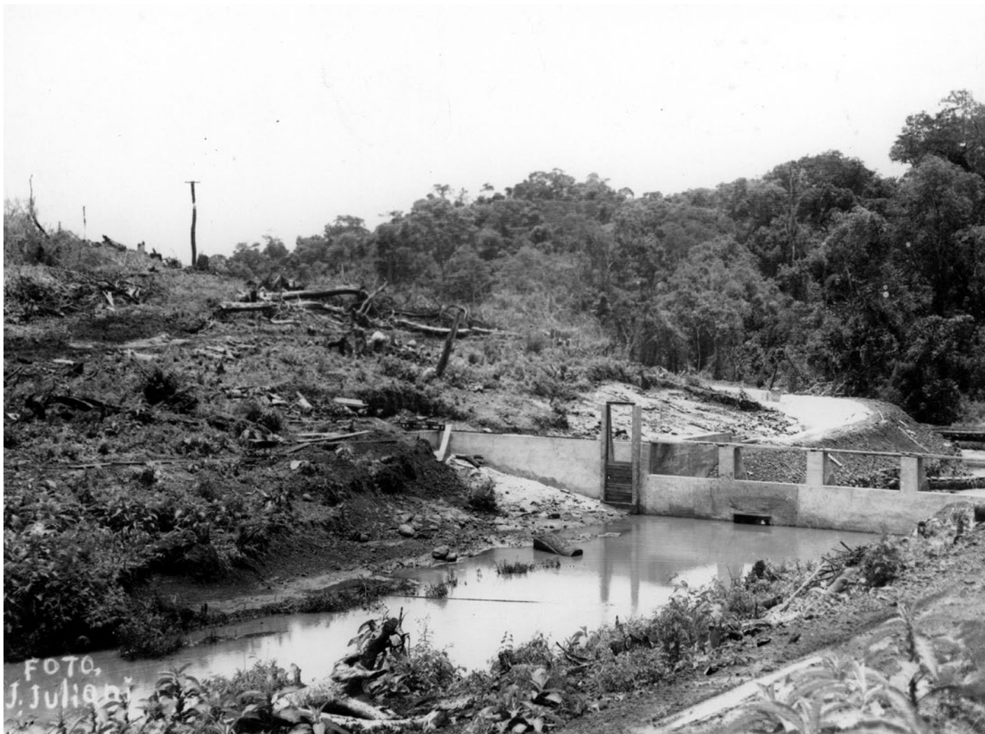
Construção da barragem para a primeira usina hidrelétrica de Londrina ACERVO Museu Histórico de Londrina / José Juliani
