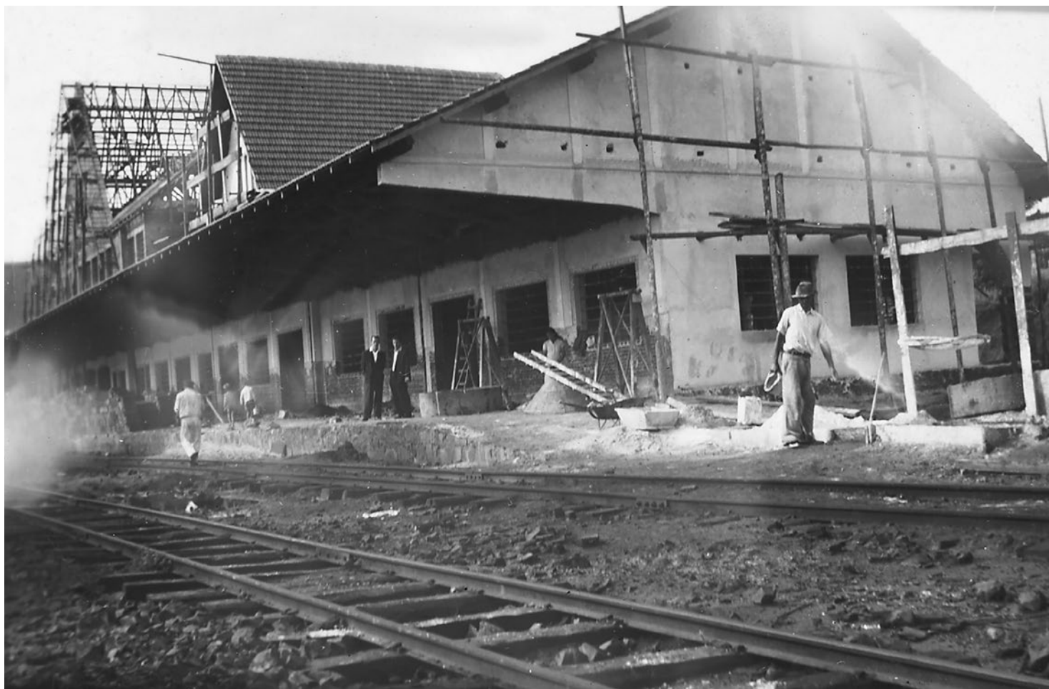
O presidente Dutra visitou as obras do novo prédio da Estação Ferroviária ACERVO Museu Histórico de Londrina
