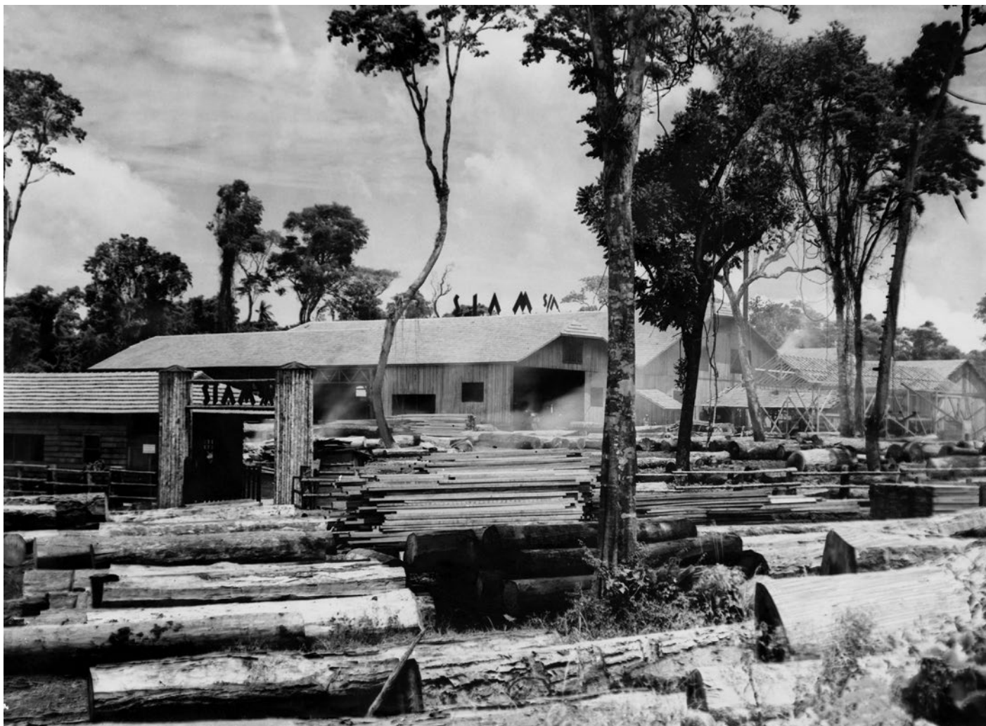
Serraria Siam, onde estavam instalados os primeiros geradores de energia elétrica de Londrina
