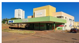
Iniciada obra de Reparo Estrutural da UPA Centro Oeste
