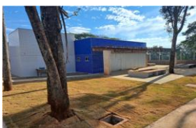
Construção PAM Sul
