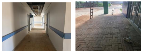
Construção PAM Leste
