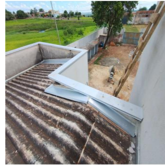
Execução Reforma UBSs Itapoã
