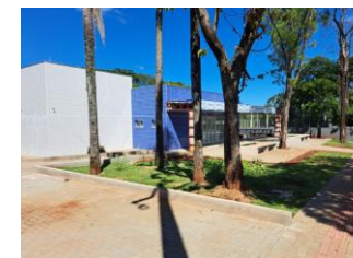
Construção PAM Sul
