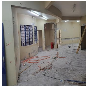
Execução Reforma da UBS Vila Ricardo
