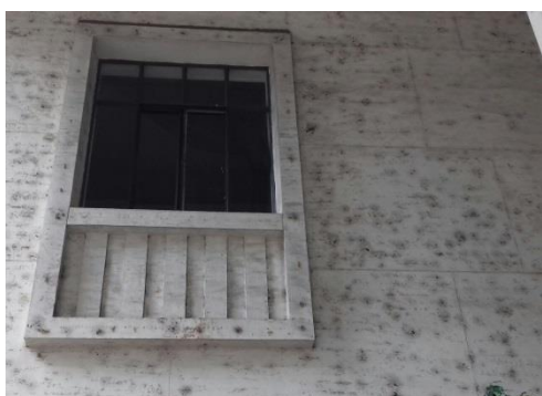
Parede antes da lavagem
