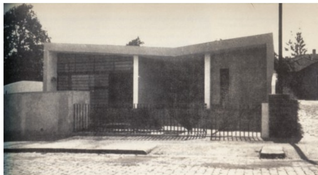
Fachada Residência Milton Ribeiro de Menezes, 1952 Fonte: SUZUKI, Juliana; 2003, p.115
