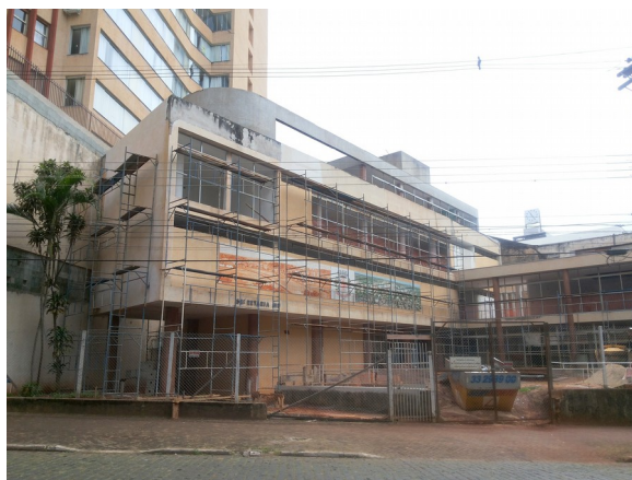
2015. Obra de Restauro. Fonte: Dir. de Pat. Histórico - PML.
