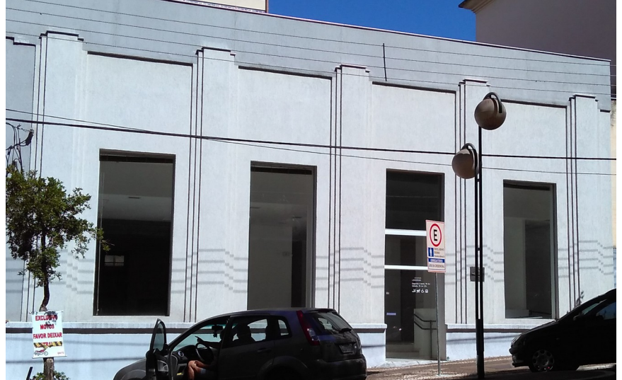
Fachada da edificação.
