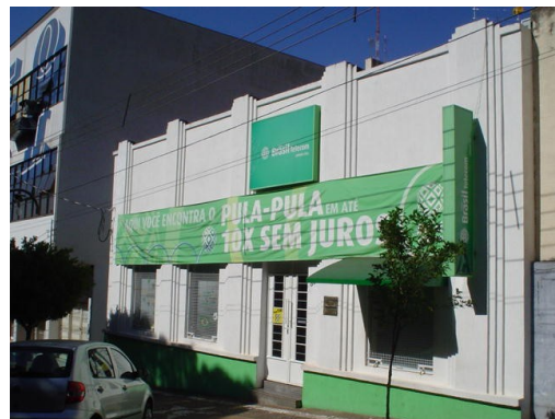
Fachada Brasil Telecom
