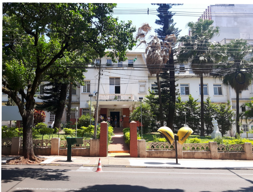
Vista recente da edificação, 2017. Fonte: Diretoria de Patrimônio Histórico-Cultural.
