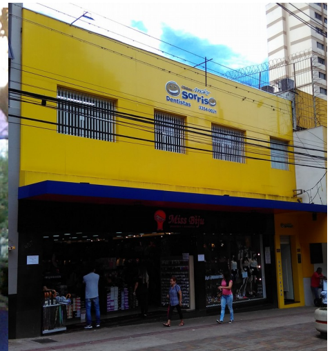
Vista recente da edificação, 2018. Fonte: Autores, abril de 2005
