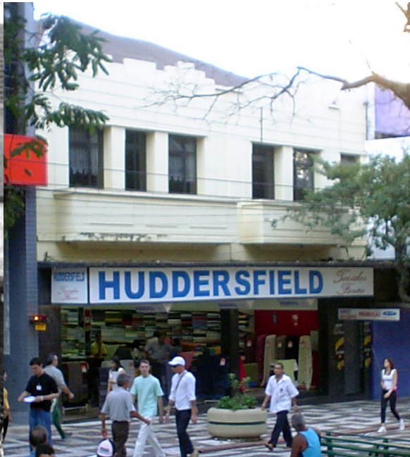
Vista da edificação Fonte: Autores, abril de 2005
