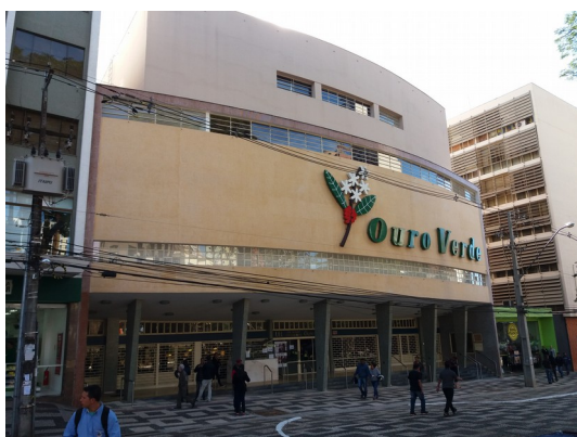
Fachada do edifício pós reconstrução
