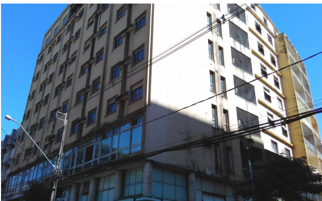
Vista da edificação Fonte: Diretoria de Patrimônio Histórico, 2018.
