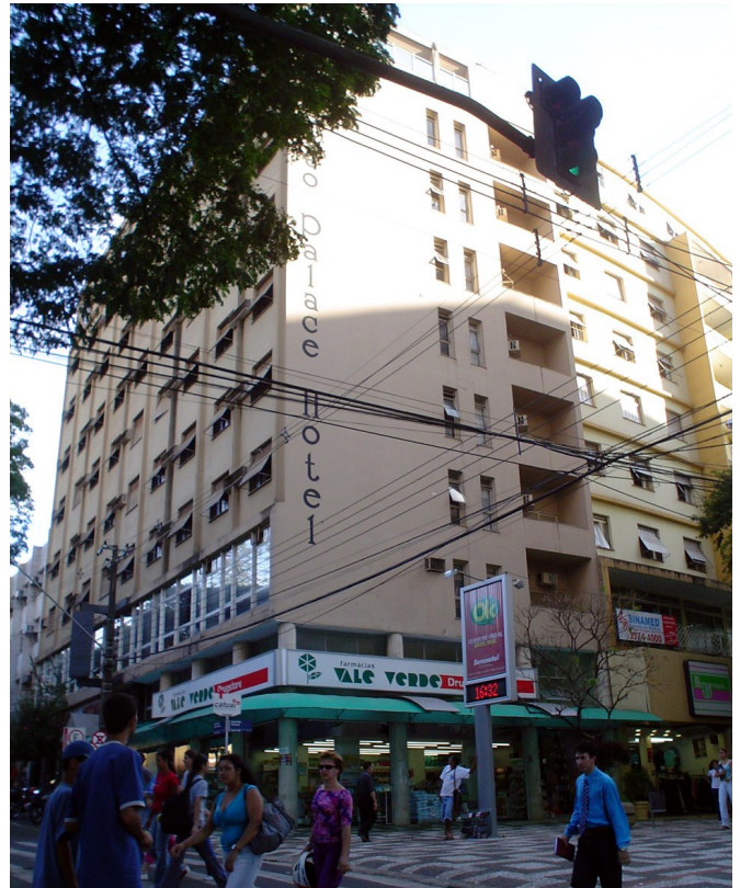
Vista da edificação Fonte: Autores, abril de 2005
