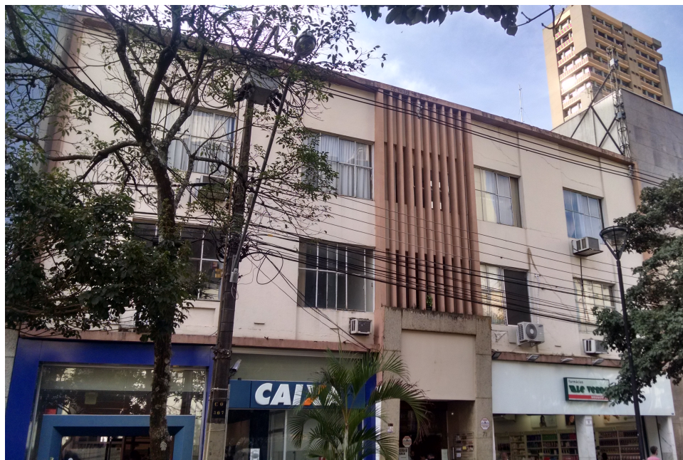
Vista da edificação, 2018.
