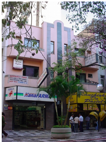
Fachada do edifício em 2003 Fonte: Diretoria de Patrimônio Histórico-Cultural, PML
