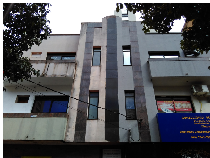
Fachada do edifício em 2018. Fonte: Diretoria de Patrimônio Histórico-Cultural, PML
