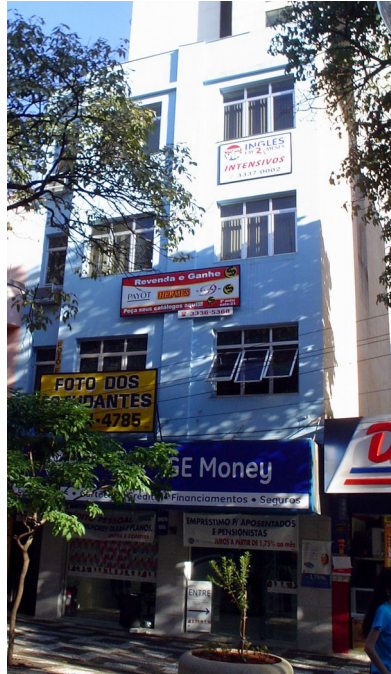
Vista da edificação Fonte: Autores, abril de 2005
