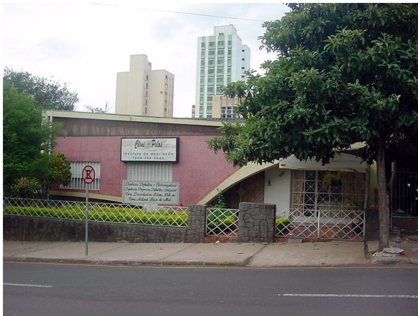
Fachada da edificação, Clínica de Depilação. Fonte: Pesquisadores, 2003
