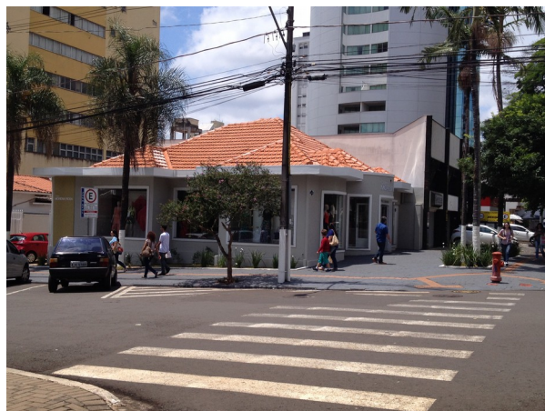
Vista lateral da edificação Fonte: Diretoria de Patrimônio Histórico-Cultural, 2017
