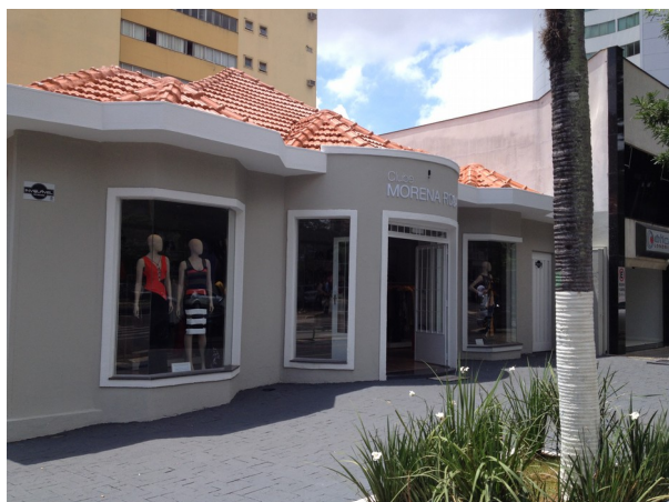
Vista frontal da edificação Fonte: Diretoria de Patrimônio Histórico-Cultural, 2017
