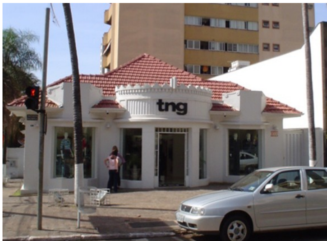
Vista frontal da edificação Fonte: Pesquisadores, 2005
