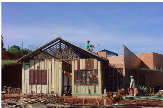
Reconstrução da antiga casa de madeira Fonte: Carla Caires, 2006
