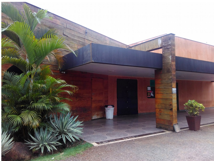
Vista frontal da edificação nova Fonte: Diretoria de Patrimônio Histórico, 2018
