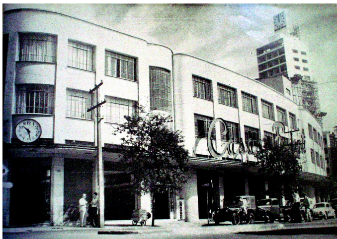
Fachada do edifício na década de 1950 Fonte: Jubileu de prata
