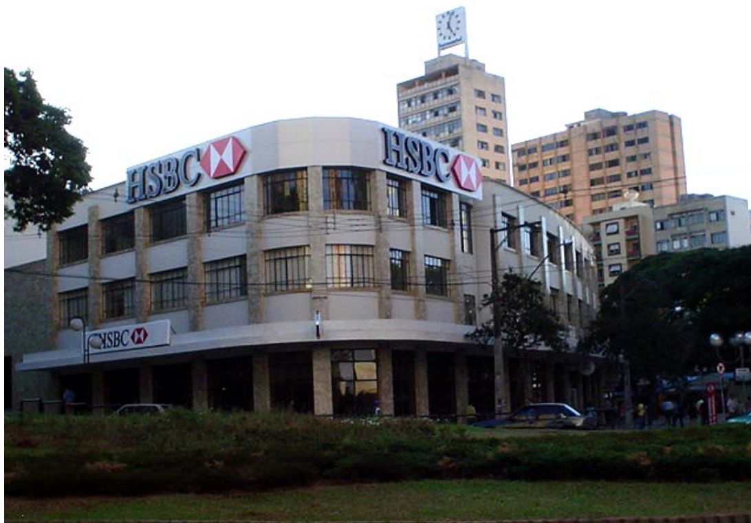
Vista da edificação, Banco HSBC. Fonte: Autores, abril de 2005.
