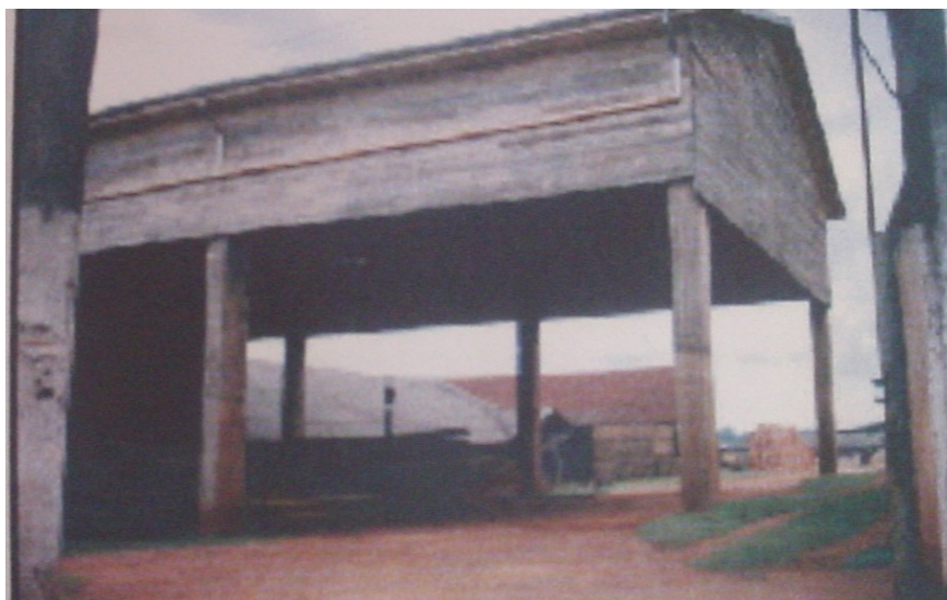
Detalhe do galpão de madeira.
