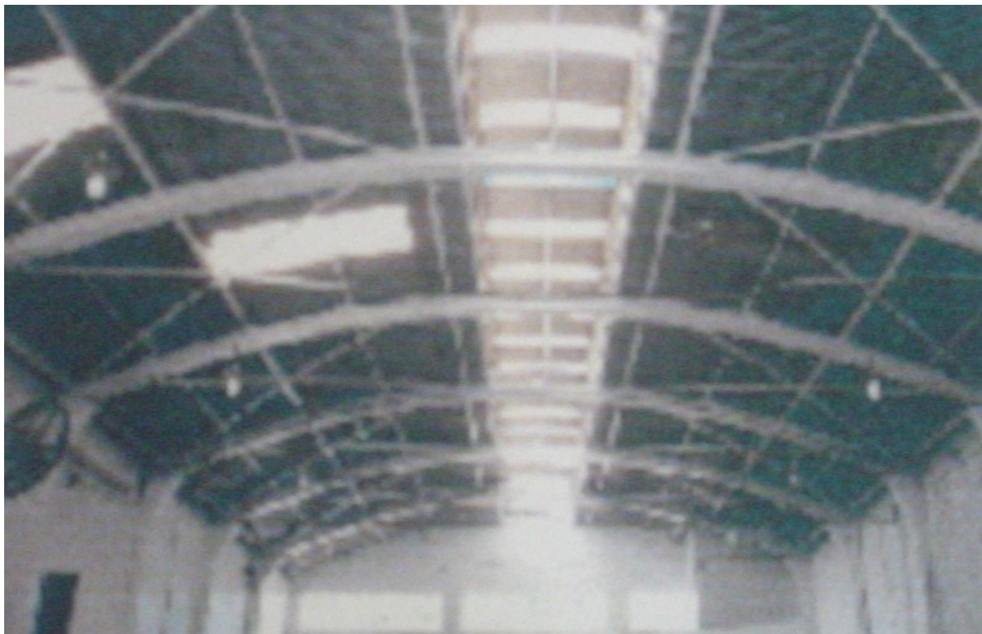
VISTA INTERNA DA COBERTURA, 2003.
