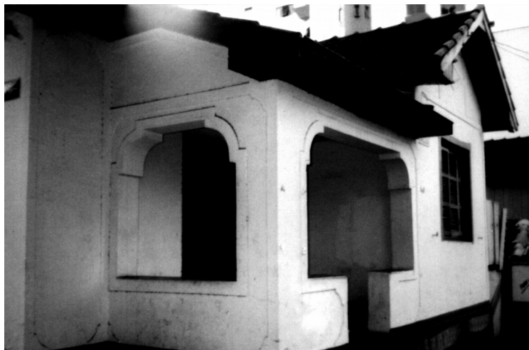
Edificação antes da reciclagem. Fonte: Marcelo Camargo, 2003.
