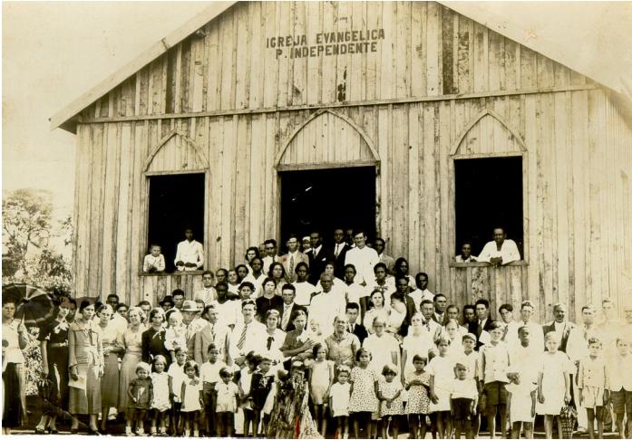
Vista externa da Igreja por volta de 1937. Fonte:
