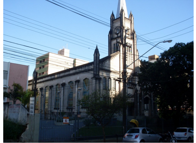
Vista externa da Igreja, 2011. Fonte: Diretoria de Patrimônio Histórico-Cultural.
