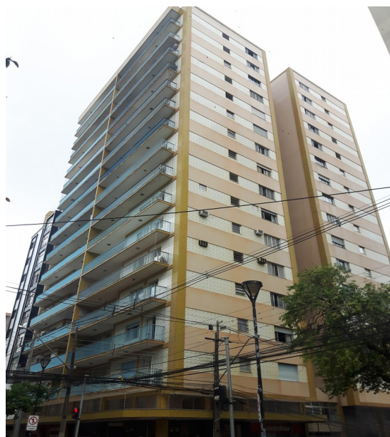
Vista recente da edificação.
