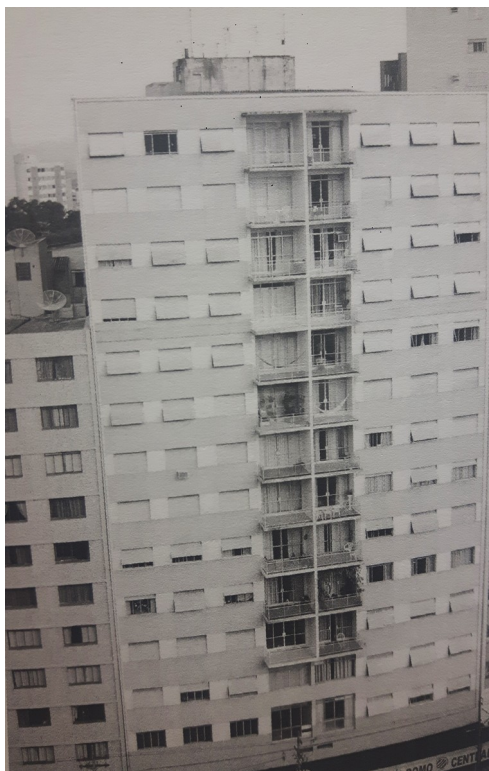
Vista frontal do edifício. Foto: Cristiana Skraba.
