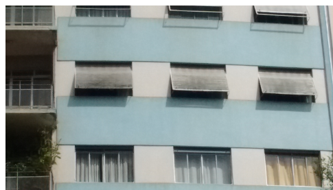
Detalhes esquadrias. Fonte: Diretoria de Patrimônio Histórico, 2018
