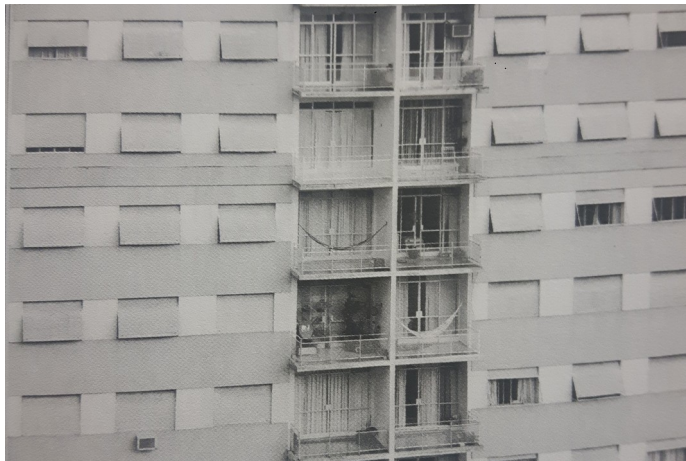
Detalhe da fachada do edifício. Foto: Cristiana Skraba.
