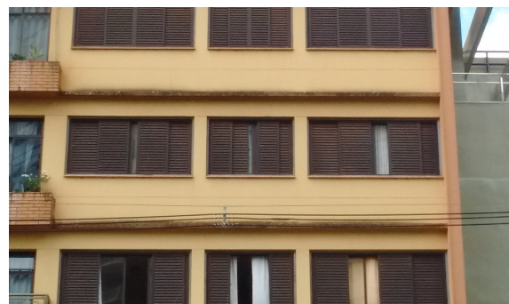
Detalhe janelas da fachada do edifício. Fonte: Diretoria de Patrimônio Histórico, 2018.
