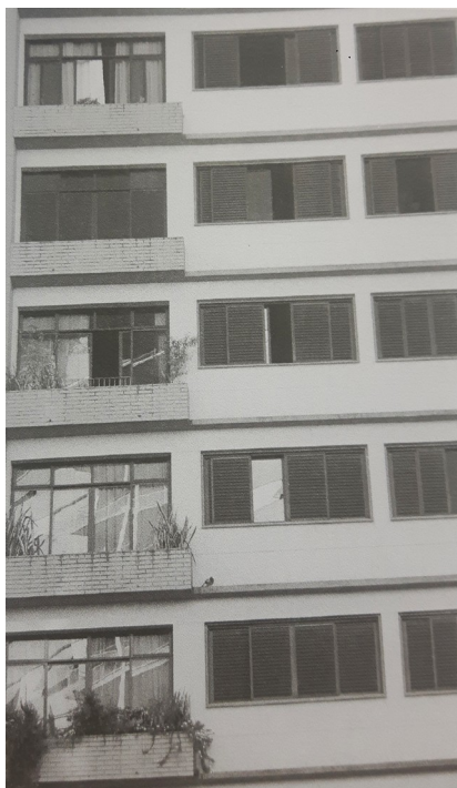
Detalhe da fachada do edifício. Foto: Cristiana Skraba
