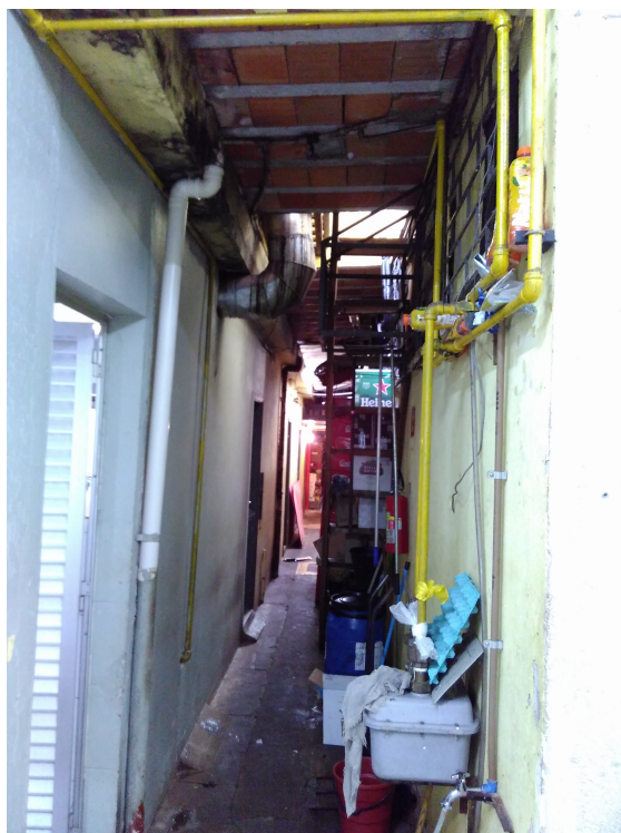
CORREDOR LATERAL ENTRE LOJAS.
