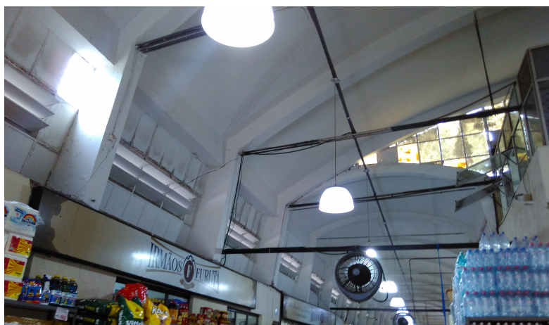
COBERTURA E ILUMINAÇÃO - INTERNO
