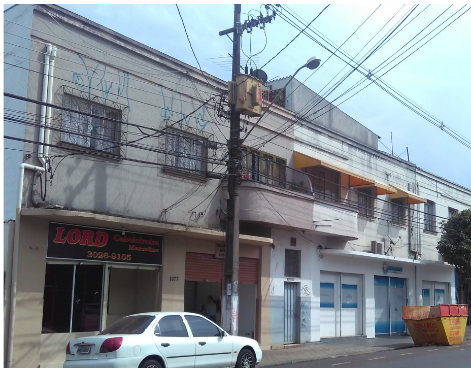
FACHADA DO EDIFÍCIO Fonte: Diretoria de Patrimônio Histórico-Cultural, 2018.
