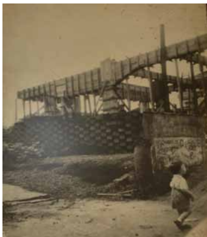
Fig. 01: Início da construção da Rádio Londrina S.A. No ano de 1952 Fonte: Acervo particular da Rádio Londrina S.A Organização: Equipe
