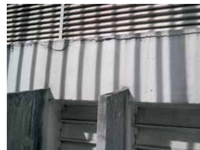
Imagem 3 - Foto referente ao estado atual dos vedos.
