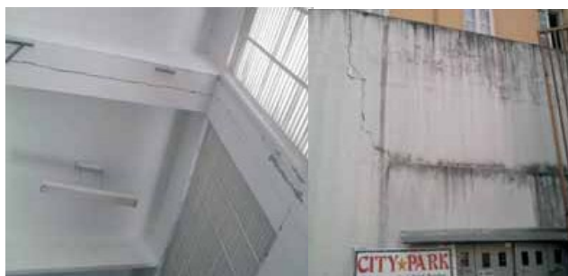
Imagem 2 - Composição de fotos referente ao estado atual da estrutura.
