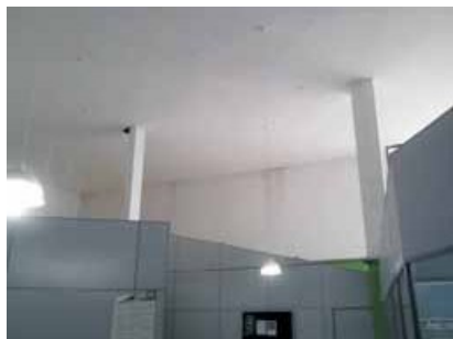
Imagem 1 - Foto referente ao estado atual da cobertura
