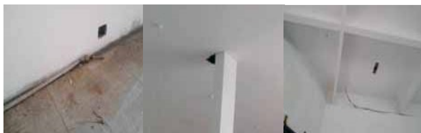
Imagem 4 - Composição de fotos referentes ao estado atual dos detalhes da edificação.
