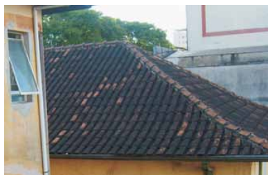
Imagem 01 - Foto referente a parte da cobertura.
