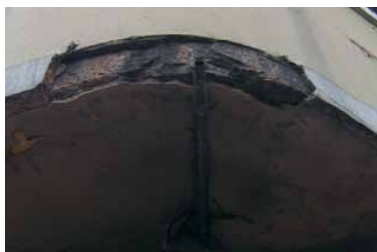
Imagem 02 - Fotos referente ao estado atual da estrutura.
