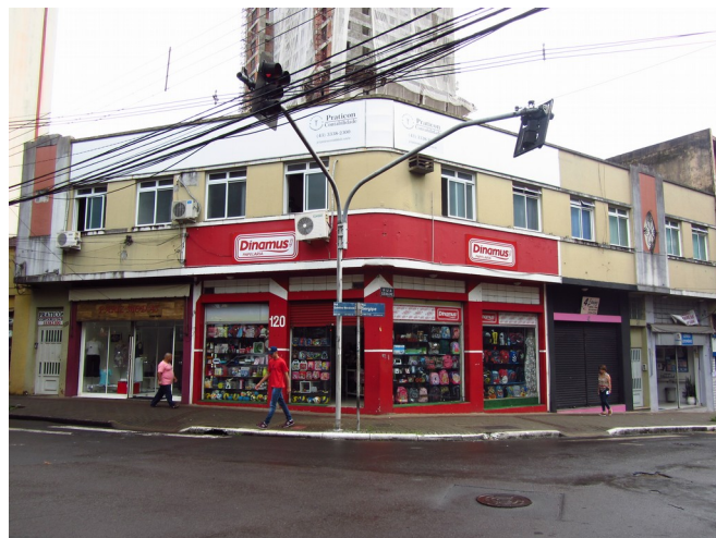
Fachada do prédio no ano de 2018.
