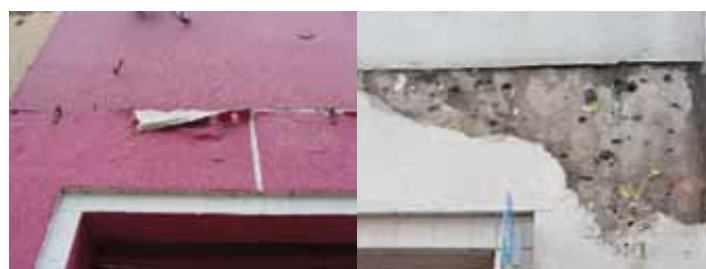
Fotos referente ao estado atual dos detalhes da edificação
