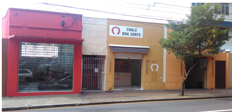
Edifício Comercial em 2018
