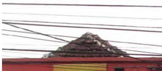
Foto referente ao estado atual de uma das coberturas.
