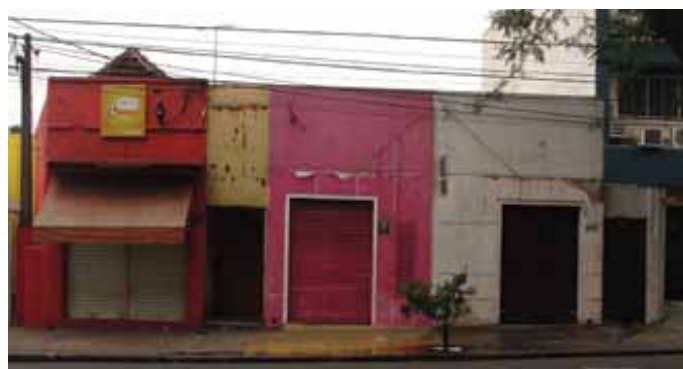
Edifício comercial em 2011
