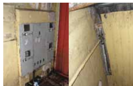
Foto referente aos detalhes da edificação.
