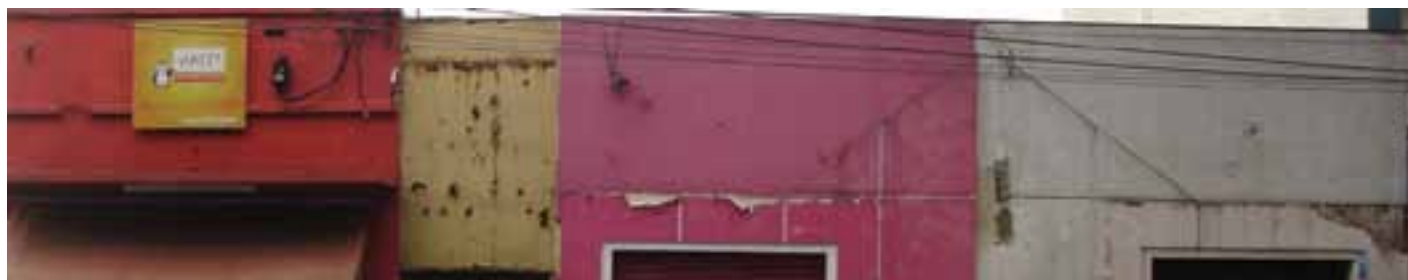
Foto referente ao estado atual dos detalhes da edificação.
