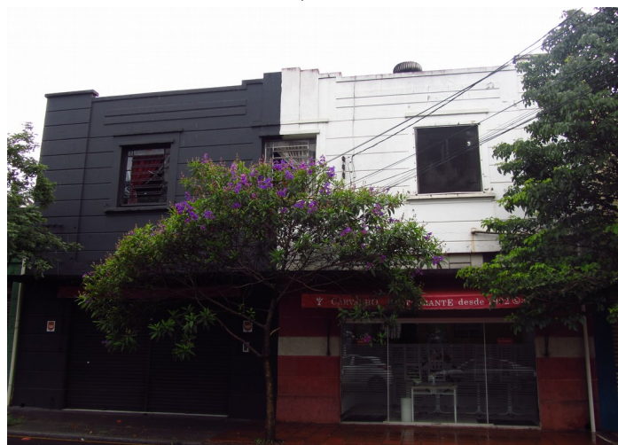
Edifício 638 Fonte: Dir. de Patrimônio Histórico, 2018
