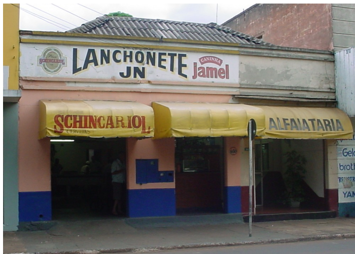
Edifício 646 Fonte: Dir. de Patrimônio Histórico, 2006
