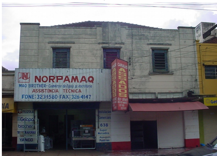
Edifício 638 Fonte: Dir. de Patrimônio Histórico, 2006
