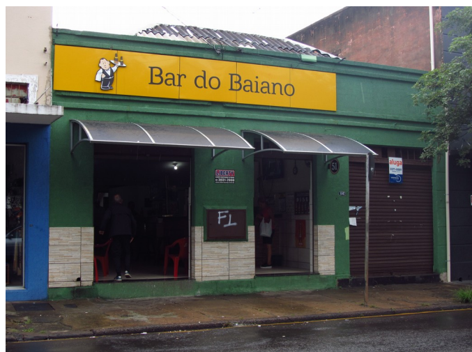
Edifício 646 Fonte: Dir. de Patrimônio Histórico, 2018
