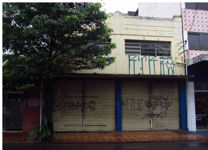
Edifício 622 Fonte: Dir. de Patrimônio Histórico, 2018
