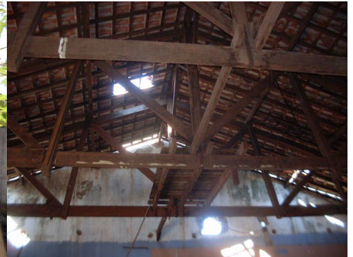
Estrutura da cobertura do barracão Fonte: Dir. de Patrimônio Histórico
