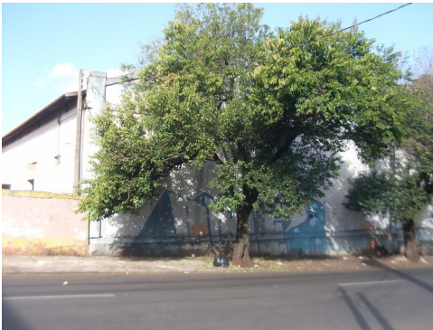
Fachada do barracão Fonte: Dir. de Patrimônio Histórico
