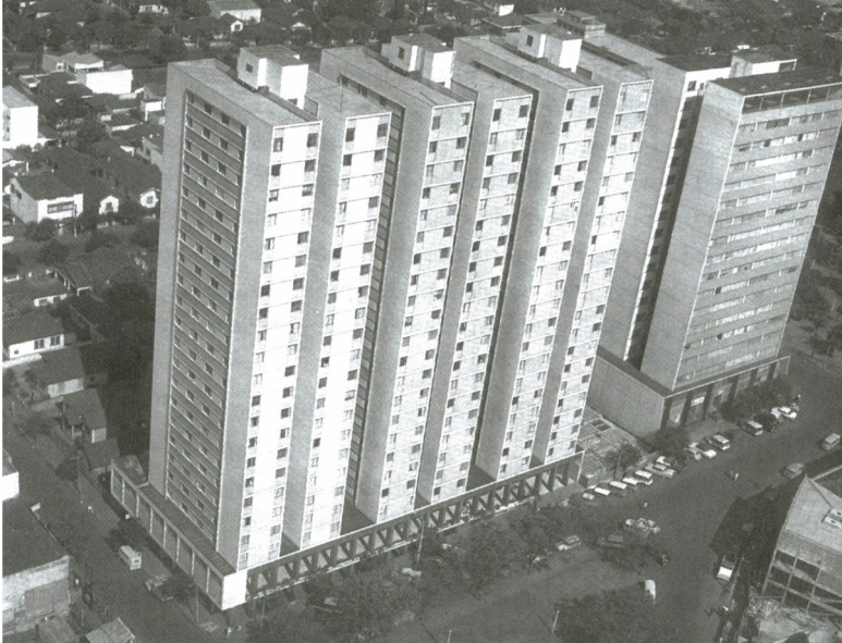
Vista Aérea Centro Comercial Fonte: CASTELNOU, Antônio.
